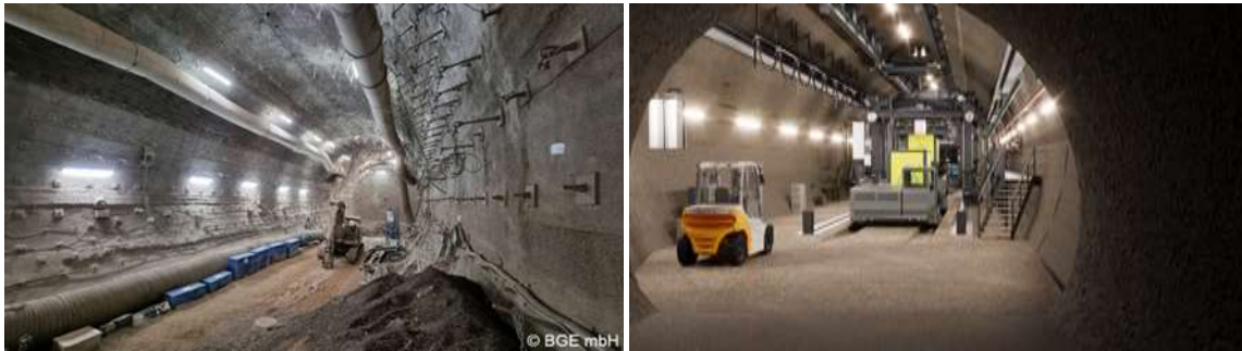
Abbildung 1: Blick in das Füllort 2. Sohle während der Sohlauffahrung links sowie Auszug aus BIM-Modell rechts Figure 1: View of the filling point 2nd level during the levelling process on the left and excerpt from the BIM model on the right
