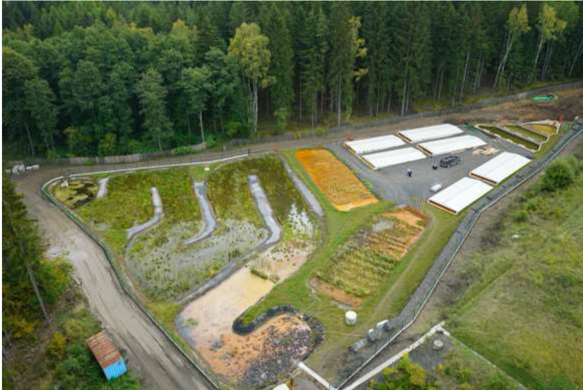
Abb. 1 Übersicht des Behandlungssystems (October 2022). Die 4 Behandlungsstufen von rechts nach links entlang der Fließrichtung des Wassers: Sedimentation, reaktive Module mit nullwertigem Eisen in geschlossenen Tanks, Biosorption und Bioreduktion im aeroben Wetland (Meander).
