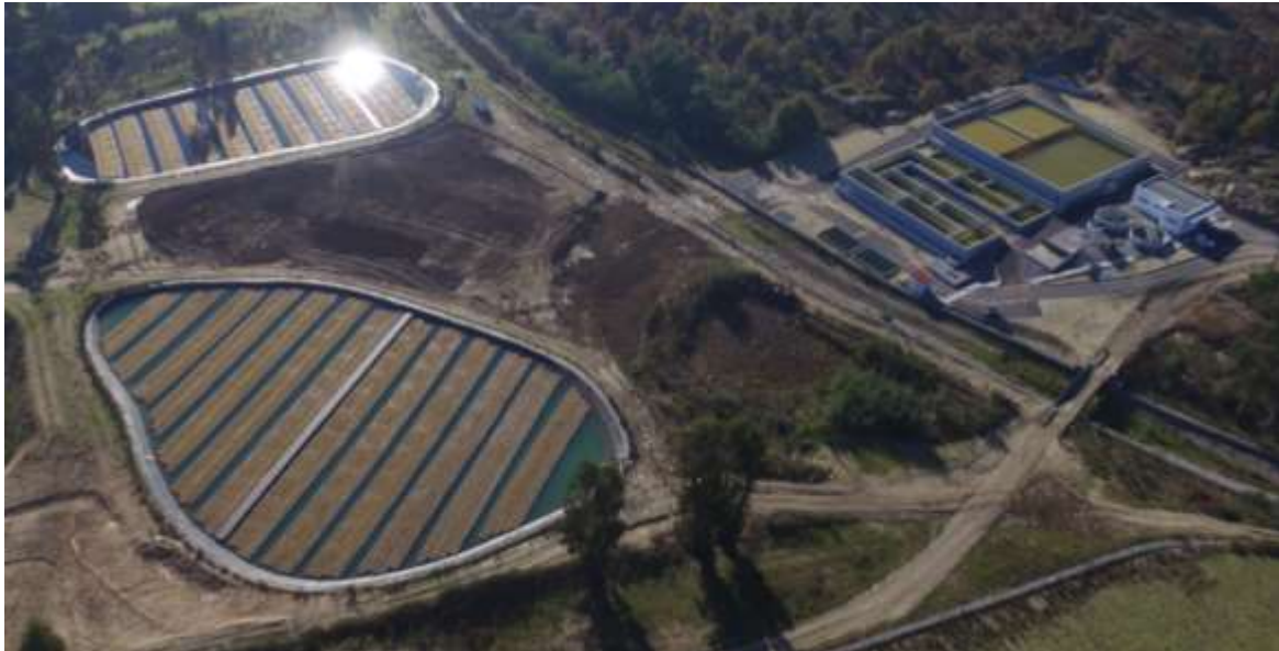
Abb. 1 Aufbereitungsanlage für Grubenwasser am Altstandort der Uranmine Urgeiriça Fig. 1 Mine water treatment station at Urgeiriça uranium mine legacy site
