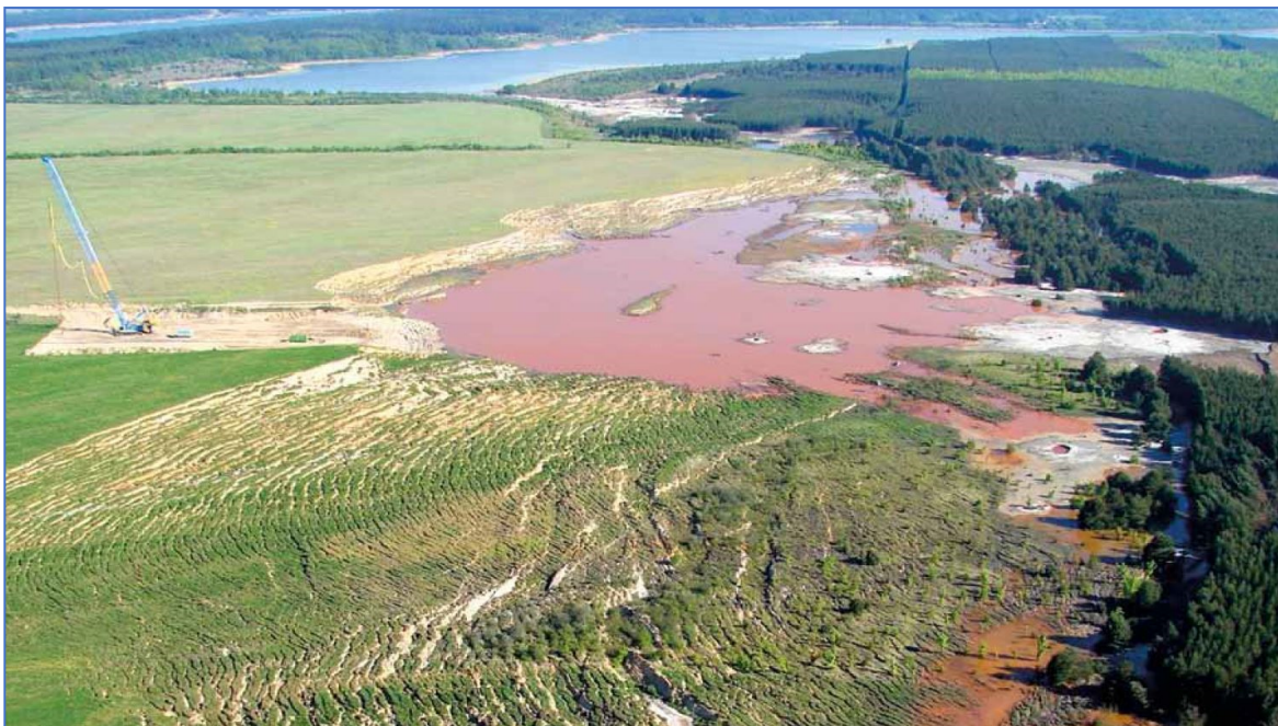
Abb. 1 Verflüssigung im Bereich der Innenkippe Seese-West (Kleptna-Niederung) Quelle: Rauhut/LMBV mbH/2011 Fig. 1 Liquefaction in the area of the inner dump Seese-West (Kleptna-Lowland)
