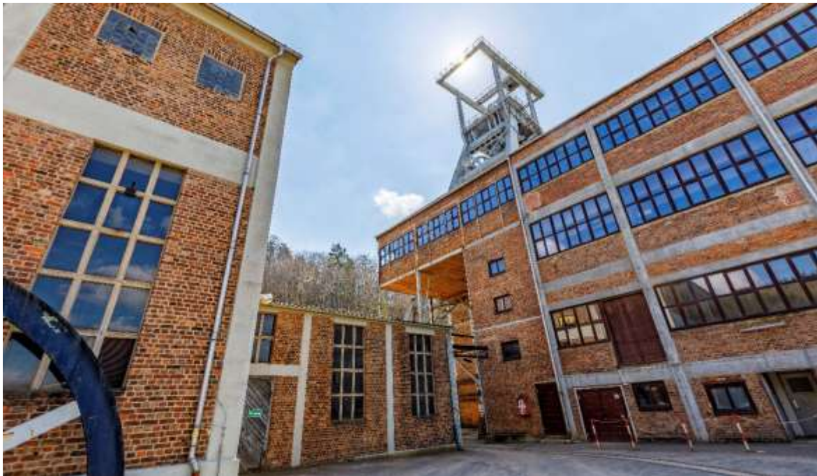
Abb. 1 Schacht 371 bei Bad Schlema – einer der künftigen zwei Präsentationsorte für das Wismut-Erbe.
