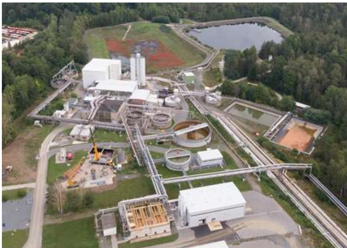
Abb. 1 Luftbilder der umgebauten AAF (unterer und rechter Anlagenteil), sowie die außer Betrieb genommene Uranabtrennungsanlage (linker Anlagenteil)
