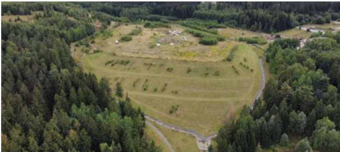
Abb. 1 Die Spülhalde I in Ehrenfriedersdorf ist einer der Forschungs- und Entwicklungsstandorte von recomine zur Entwicklung ganzheitlicher Lösungen für Bergbauabfälle.
