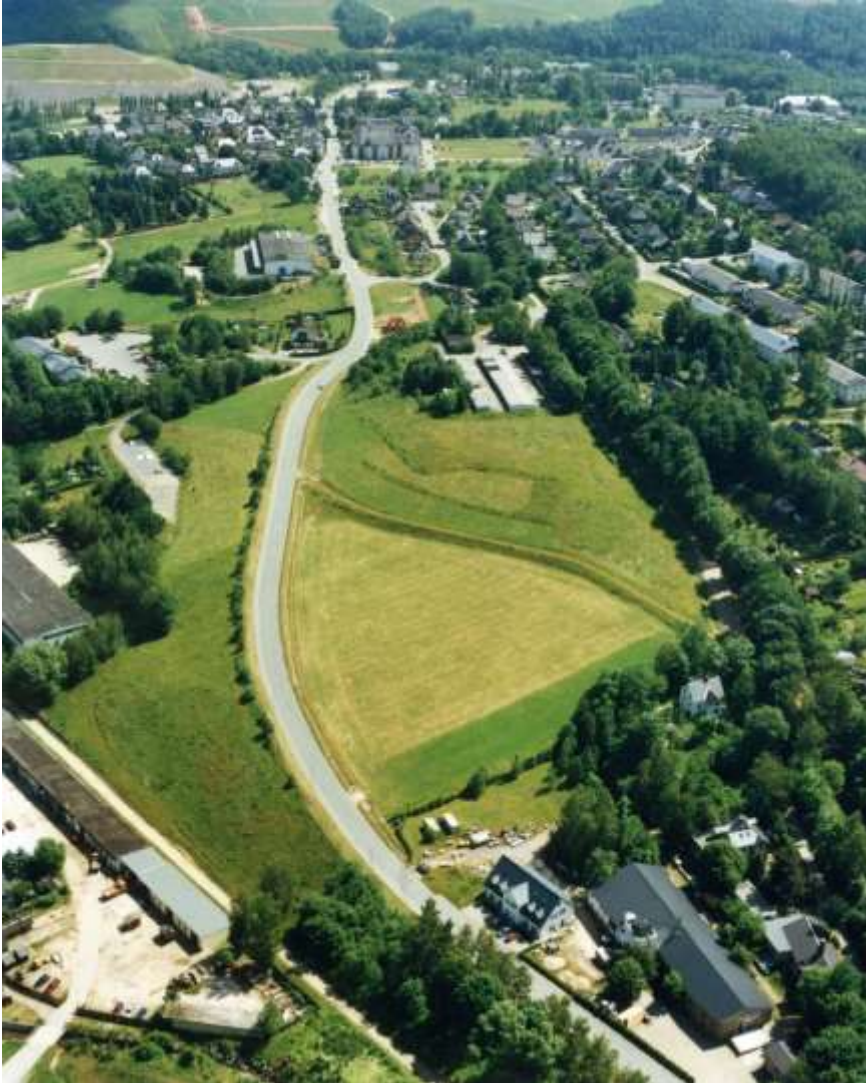
Abb. 2 (Bad Schlema, Schacht 13b, 2005 – Unternehmensarchiv Wismut GmbH) Fig. 2 (Bad Schlema, mine 13b, 2005 – Unternehmensarchiv Wismut GmbH)
