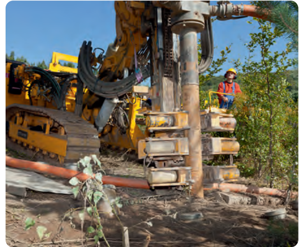
Versatzbohrung 2014 in Bad Schlema mit einem Raupenbohrgerät
