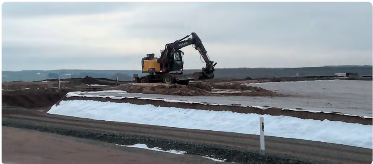
Beginn der Immobilisateinlagerung im Januar 2022
