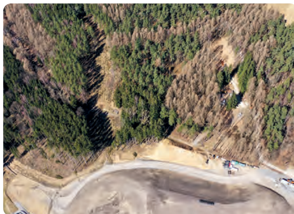
Sanierungsbereich Gänge 57 (l.) und 58 mit unterhalb liegender Deponie „Am Knochen“
