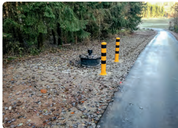
Fertiggestellte Straße mit Schutzeinrichtung eines Kontrollschachtes
