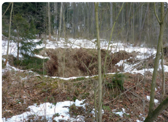
Tagesbruch auf Gang 58
