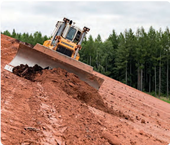
2017: Abdeckung der Böschung
