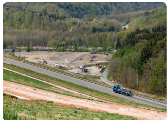
Ein Teil des Materials wird zur benachbarten Halde 371/I transportiert
