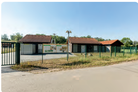
Sanierungsgebiet Gessental, Pumpstation
