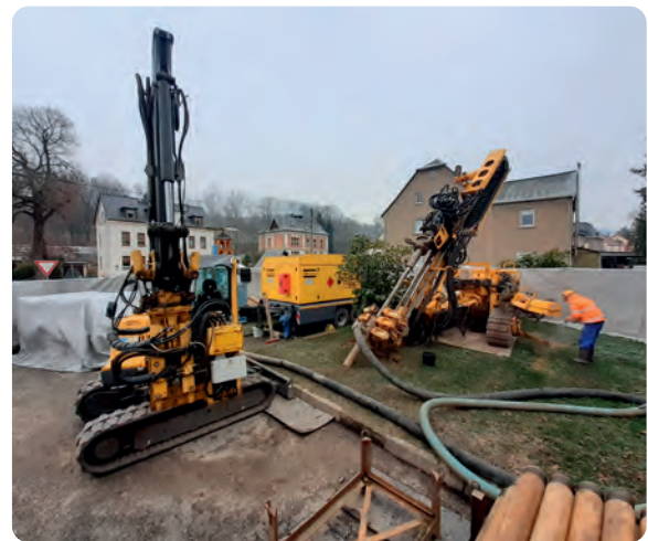
Versatzbohrung 2021 in Bad Schlema
