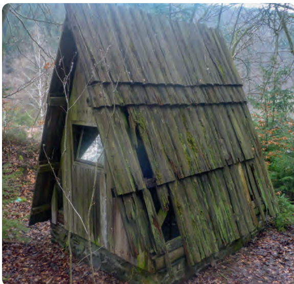
Der Schacht 15 dient während der Arbeiten als Wetter- und Fluchtweg
