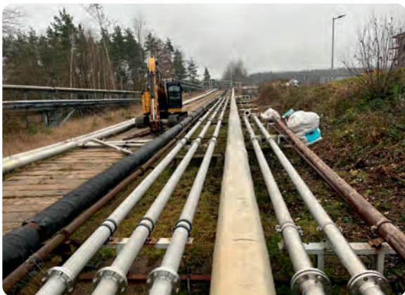
Die Rohrleitungstrasse der ehemaligen Uranentsorgung wird zurückgebaut
