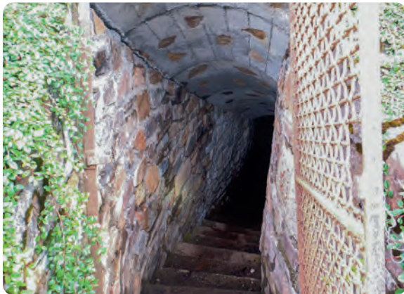
Mundlochbereich des Stollens 4 in Niederpöbel
