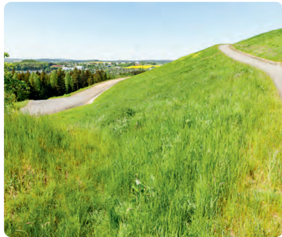
Fertig sanierter Abschnitt mit Gerinne und Fahrweg 2022
