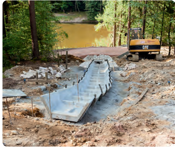
2015: Bau eines Gerinnes
