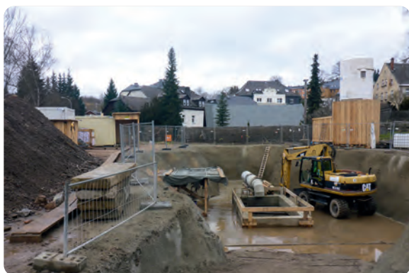
Baugrube am Schacht Nr. 25 mit betoniertem Schachtkragen
