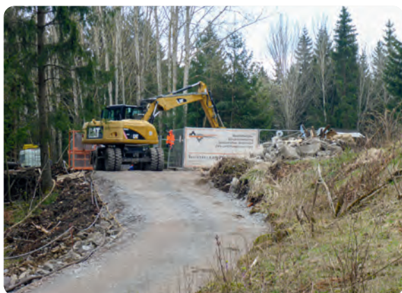
Zuwegung und Baustelleneinrichtung am Schacht 206
