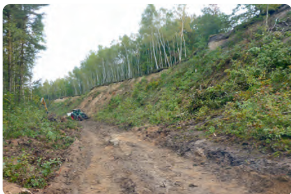
Rodungsarbeiten in einem ehemaligen Kiesabbau in der Nachbarschaft der IAA Dänkrütz 2
