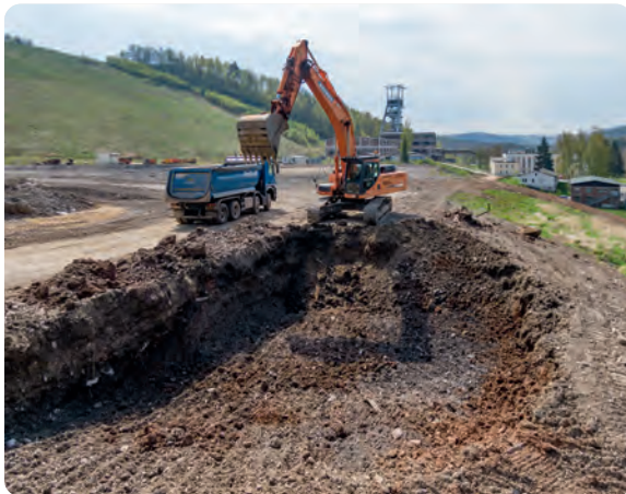
Auf der Betriebsfläche Nord des Schachts 371 hat die Flächensanierung begonnen
