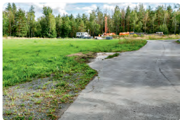
Die Bohrung findet auf dem sanierten Gelände des verwahten Schachts 398 statt
