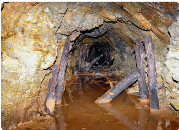
Der Zustand des Stolln Grißbach nach der Öffnung
