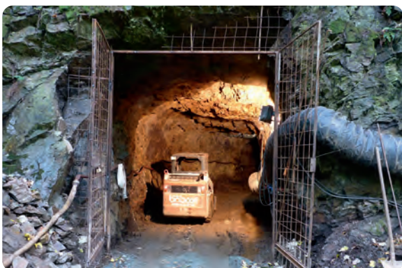
Aufgewältigter Mundlochbereich während der Sanierung
