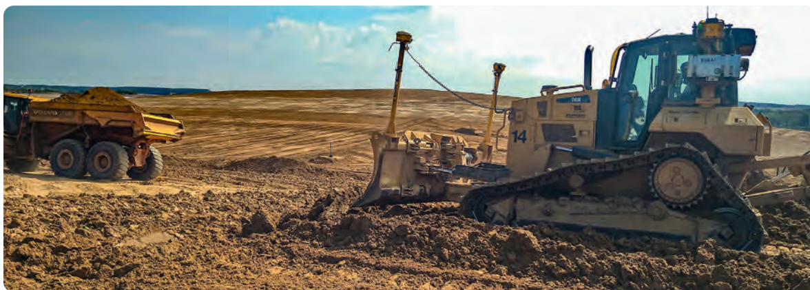
Die letzte Lage Speicherschicht nach Regelprofil V1Dr wurde in der Teilfläche 4 im August fertig gestellt
