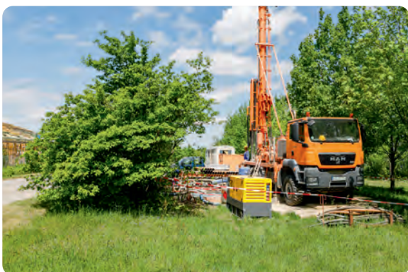
Der Bohrturm wurde exakt auf die Kontrollstrecke ausgerichtet
