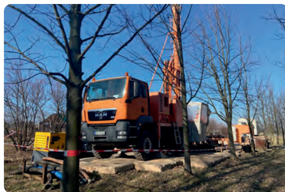
Die 283 Meter tiefe Bohrung liegt innerhalb des Landschaftsschutzgebietes Sächsische Schweiz
