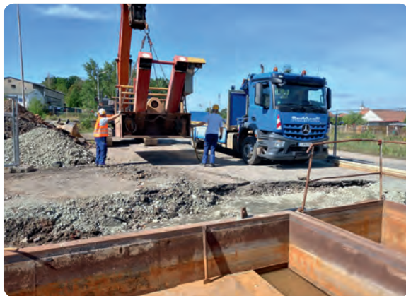
Vor den Abtragsarbeiten wurde eine Reifenwaschanlage aufgebaut
