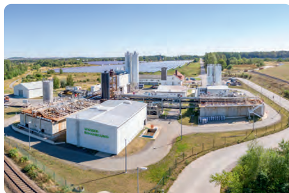
Wasserbehandlungsanlage Ronneburg hier wird das Flutungswasser des Ronneburger Reviers behandelt
