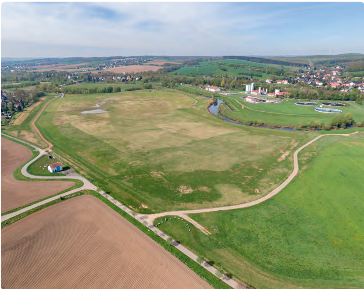
Die Bergehalde Crossen ist abgetragen und die sanierte Fläche steht für den Hochwasserschutz zur Verfügung
