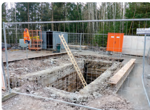
Freigelegter Schachtkopf des Schachts 206
