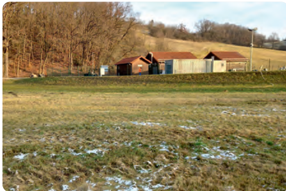
Die Pumpstation im Gessental ist durch einen Damm vor Hochwasser geschützt
