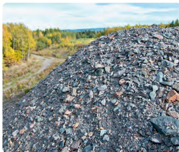
2012: Sanierungsarbeiten auf der Halde 310
