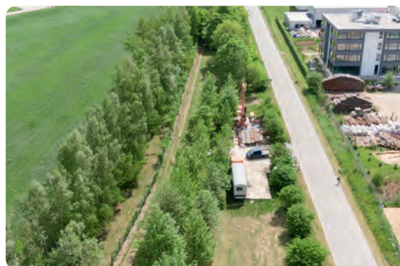
Bohrstelle an der Königsteiner Straße am Rand des Betriebsgeländes
