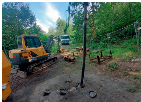
Die Hohlräume wurden mit 450 m 3 Beton verfüllt
