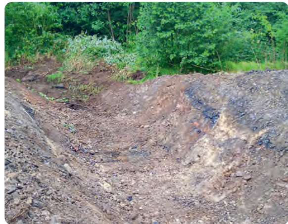
Bereich Durchlass Alte Katzendorfer Straße nach Abbrucharbeiten
