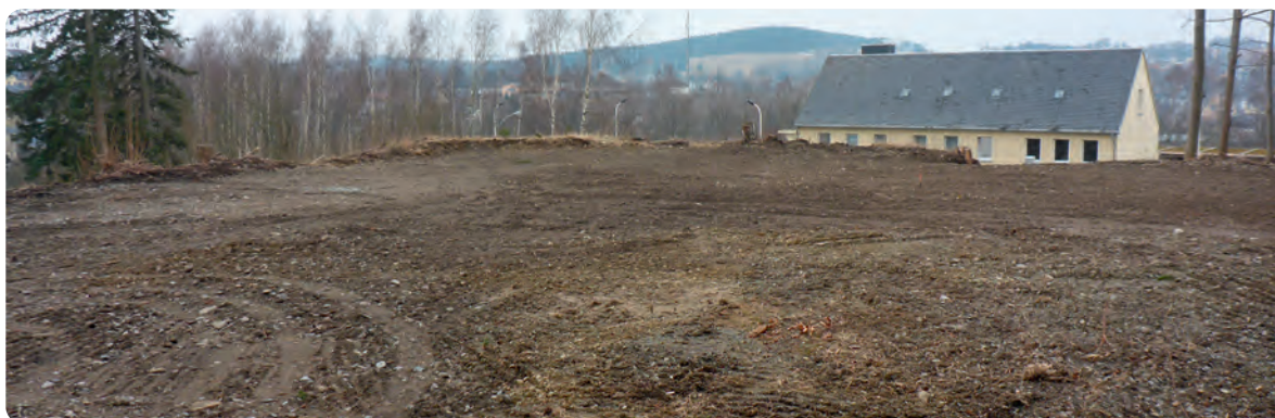
Die für die Sanierung vorbereitete Betriebsfläche Mitte März 2022
