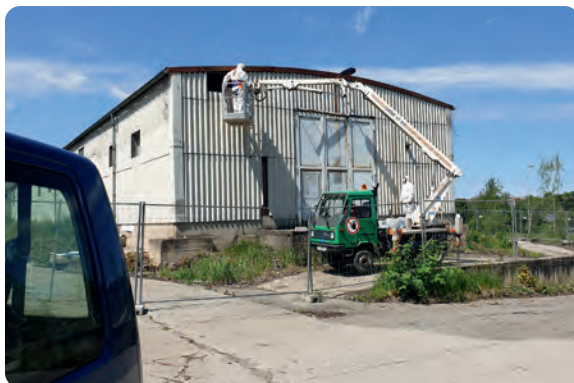
2019 wurde unter anderem eine Lagerhalle abgerissen
