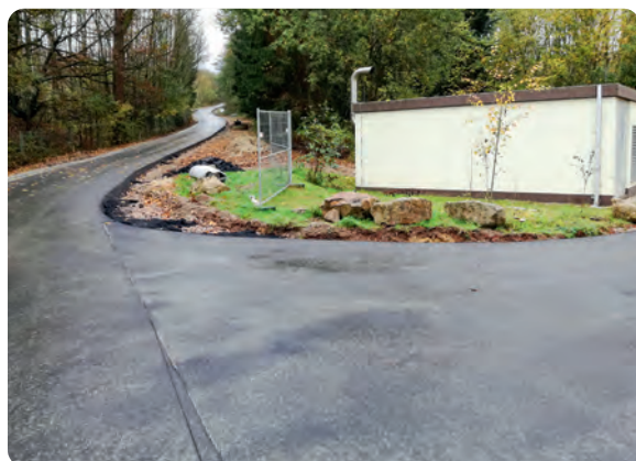
Beginn der Auffahrtsstraße an der Trafostation im Hauptdammvorland
