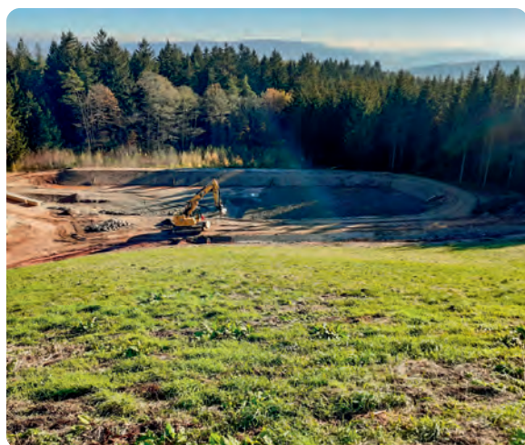
Bau einer Versickerungsfläche als Bestandteil der letzten Baumaßnahme auf der Halde 310
