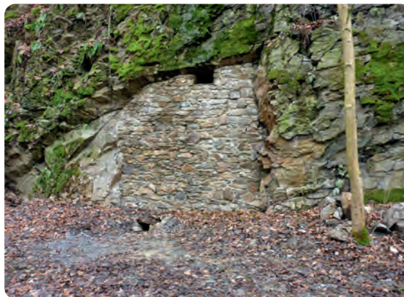
Mundlochbereich Stolln Grißbach nach der Verwahrung
