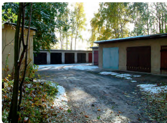
Der Garagenkomplex auf der Betriebsfläche Uranus I (2003)
