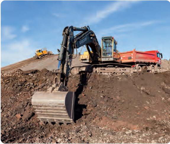
2014: Abtrag an der Haldenböschung
