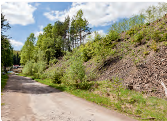
Vor der Sanierung 2012 sah der gleiche Bereich noch wüst aus
