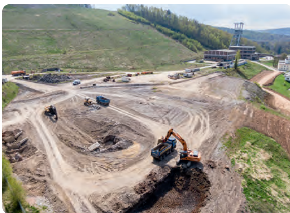
Die Böschung hinten rechts im Bild wird mit einer Vorschüttung abgeflacht werden
