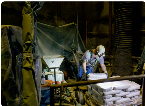
Die Betoniermaschine auf der oberen Verwahrungsbühne muss kontinuierlich befüllt werden
