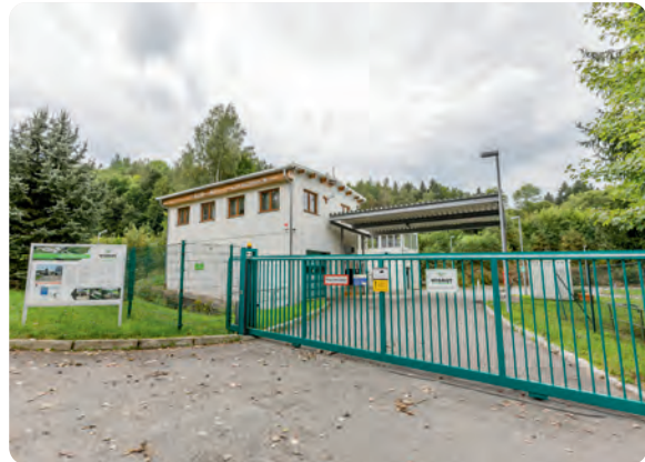
Die WBA Pöhla arbeitet im Regelbetrieb
