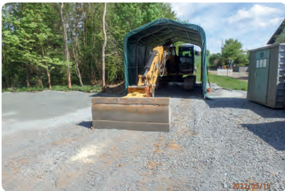
Zum Schutz der Heilquellen in Bad Brambach wurde für die Technik ein spezieller Stellplatz angelegt
