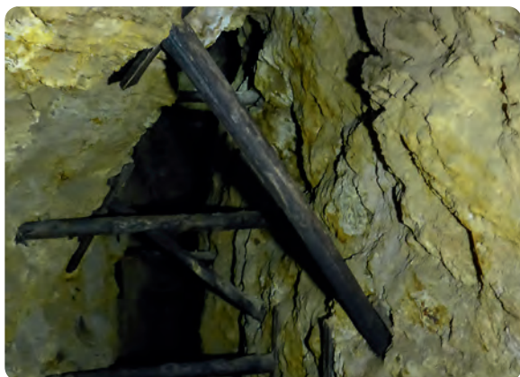
Leer stehender Abbaublock auf Gang 58 vor der Verwahrung
