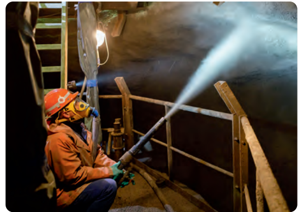
Verwahrung des Schachts 208 in Bad Schlema
