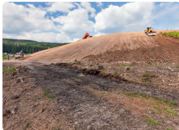
Sanierung der Böschung des Trockenbeckens 2013
