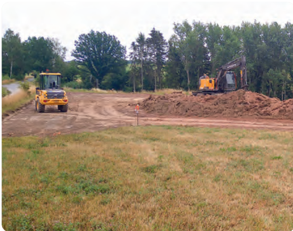
Vorbereitung der Lagerflächen für Erdstoffe am ehemaligen Bahndamm der Katzendorfer Straße
