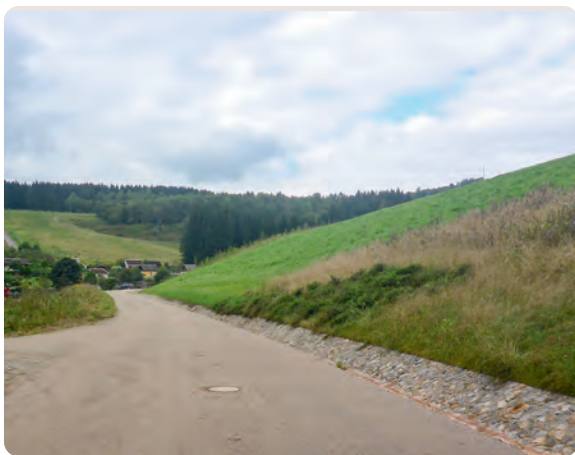
Fertiger Wasser- und Wegebau am Haldenfuß im Bereich der angrenzenden Gartenanlage
