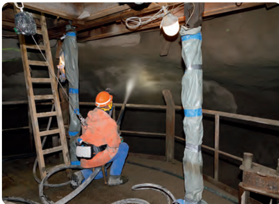
Der erste Ausbruchring der Kontur des Betonscherppropfens wurde gesichert
