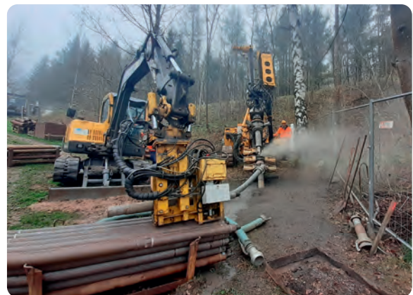
In diesem Bereich bohrten Mitarbeiter zehn Löcher mit einer Gesamtlänge eines halben Kilometers
