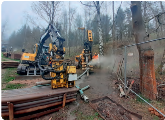
Letzte Verwahrung tagesnaher Grubenbaue an der Eichhörchenquelle in Bad Schlema
