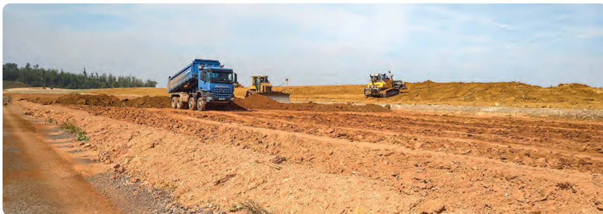
Aufwendiger Aufbau der Endabdeckung im Übergangsbereich zwischen den Regelprofilen V4 und V1Dr in der Teilfläche 7
