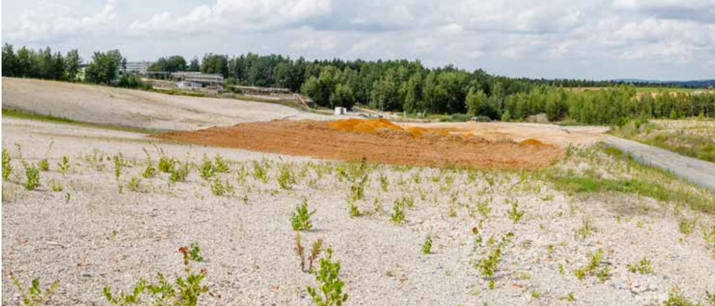
Sondereinlagerungsbereich der Halde Schüsselgrund für die immobilisierten Rückstände der Wasseraufbereitung
