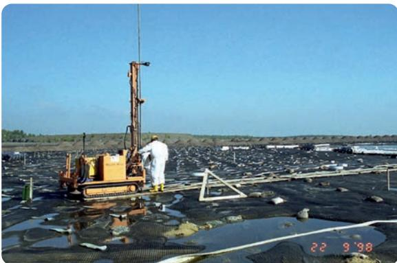
Einstechen der Drainagedecke für die Zwischenabdeckung, 1998
