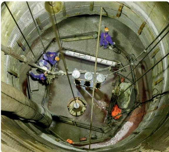
In ca. 40 Meter Teufe wurde der Beton in die Kontur gegossen
