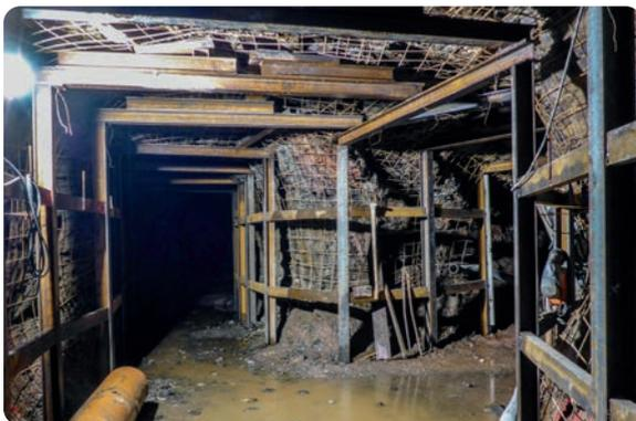
Sicherungsarbeiten im Stollen 4 am Streckenkreuz zur Gangstrecke 338
