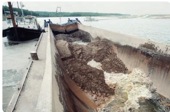
Subaquatische Verklappung: 2003 wurde von Booten aus eine Abdeckschicht auf die Tailings aufgetragen
