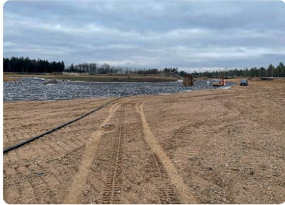
Nachdem die Zwischenabdeckung aufgebracht ist, wird die Anlage konturiert, abgedeckt und begrünt
