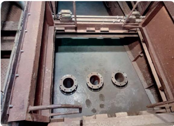
Verfüllte Schachtröhre mit den Stahlrohren für späteres Monitoring
