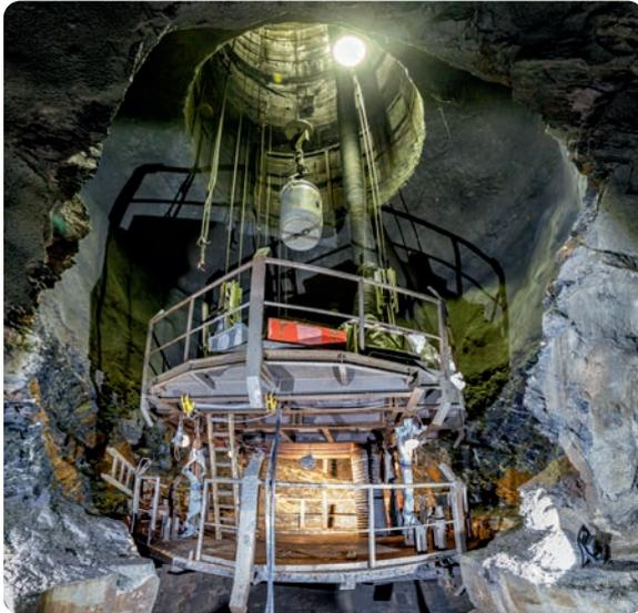
Die Kontur des Betonscherpfropfens im Schacht 208 ist fertig. Das Bild von 2022 zeigt den Blick aus der Maschinenkammer auf die Verwahr Bühnen
