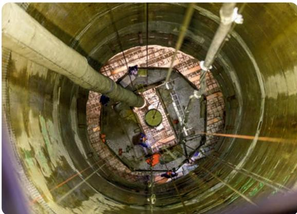
Blick in die Schachtröhre auf die Schalung der Tragplatte. In der Mitte hängt die Betonierbühne darüber.
