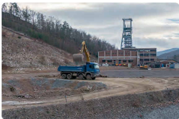
Abtrag des Haldenmaterials
