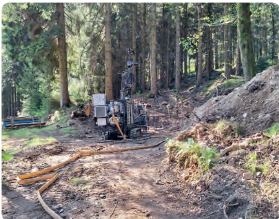
Stollen 223, Bohrarbeiten im Bereich des Forstweges
