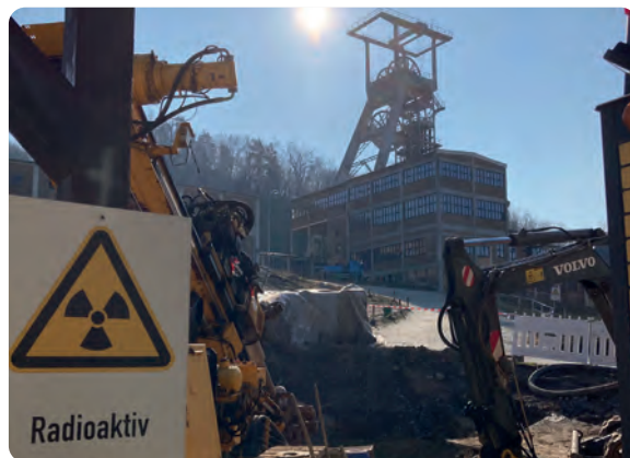
Die Sickerwässer der Halde werden künftig in den Schacht 371 verstürzt
