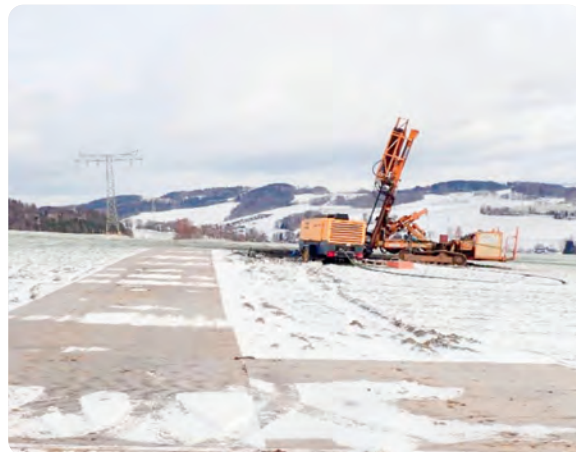
Bohrarbeiten am Schurf 204
