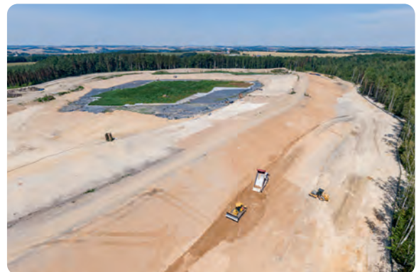
Sanierung des Altstandorts Absetzanlage Dänkritz 2
