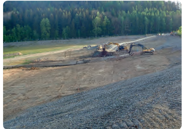
Letzte Arbeiten Ende April
