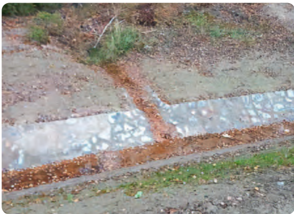
Neu gepflasterter Hanggraben Nord
