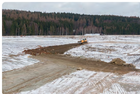
Die Massen werden auf dem Plateau der Halde 371/I eingearbeitet
