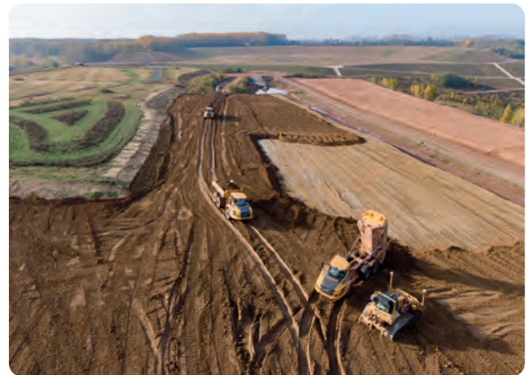
Endabdeckung im Becken B der Absetzanlage Culmitzsch Ende Oktober
