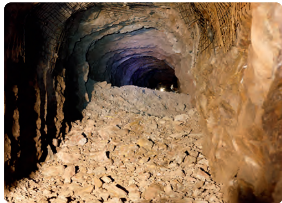
Der Durchbruch mit Blick in den vom Querschlag 33 aufgefahrenen Teil der Feldstrecke
