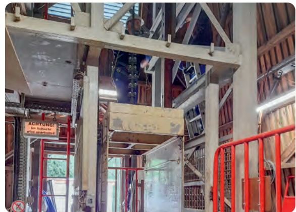
Ausbau des alten Förderkorbs
