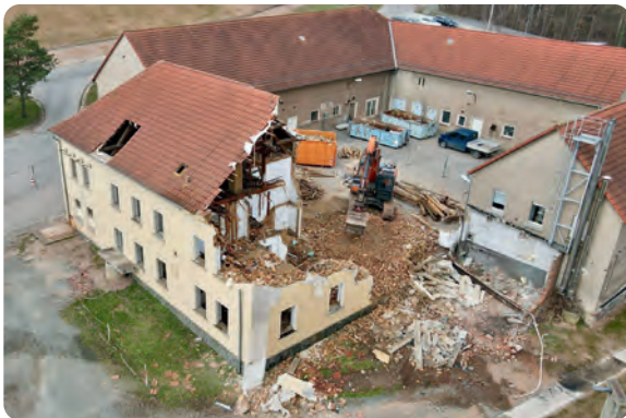
Abriss des Verwaltungsgebäudes
