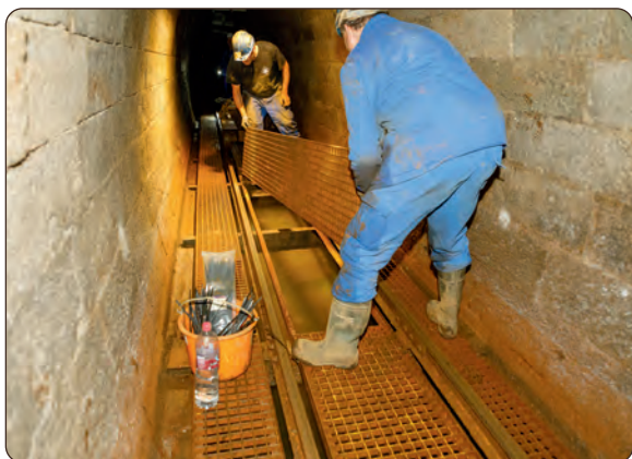
Für die Beräumung musste die Fahrgang über der Wasserseige geöffnet werden
