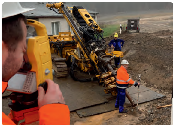
Einrichtung der Baustelle am Schacht 371
