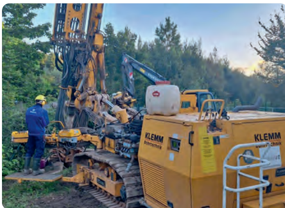
Die Spezialisten der Wismut GmbH bohrten bis in 46 m Tiefe
