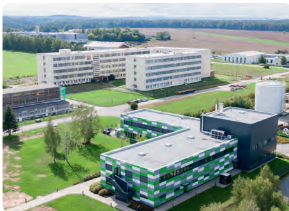
Ersatz für die alten Häuser - das Funktionalgebäude, 2022
