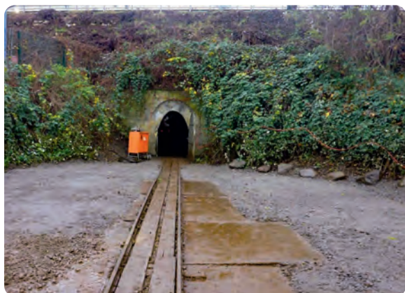
Wieder hergerichtete Baustelleneinrichtungfläche am Mundloch des Tiefen Elbstolln
