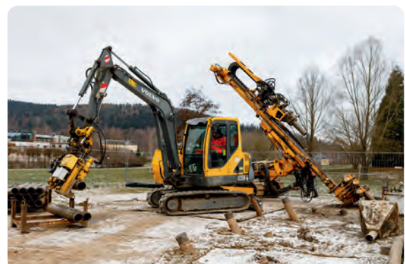
Nach dem Verfüllen bergen die Bohrspezialisten die Verrohrung
