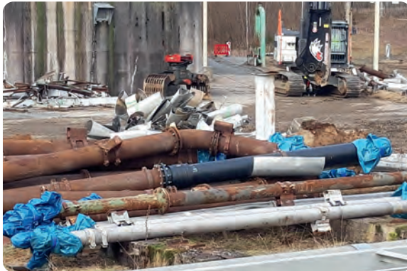
Demontierte Rohre an den Uransilos
