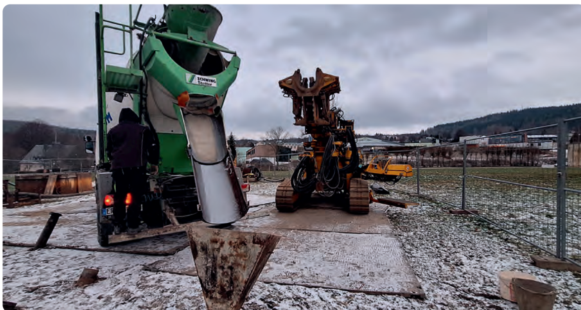
Im Kurpark von Bad Schlema wurden die ersten Bohrlöcher verfüllt
