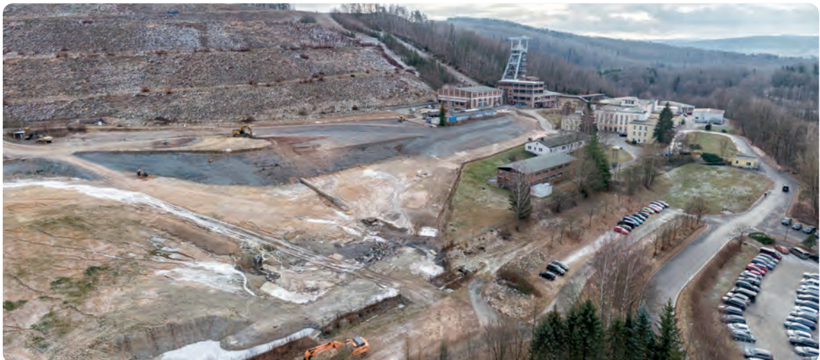
Betriebsfläche Nord im Januar 2024
