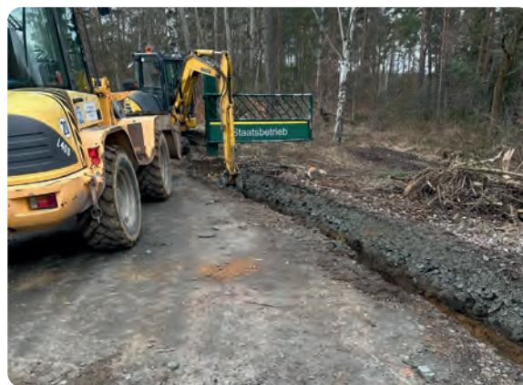
Das erste Teilstück bis zum Zugang zur ehemaligen Betriebsfläche Schacht 398 ist geschafft
