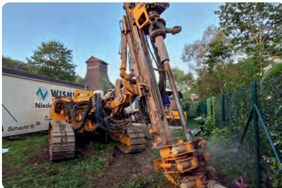
Bohrung am Schacht 15 IIb in Bad Schlema
