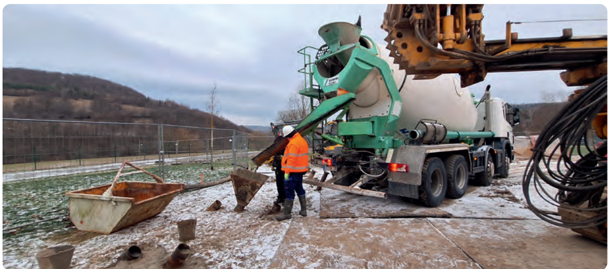
Am 15. Januar wurden die ersten fünf Bohrungen verfüllt
