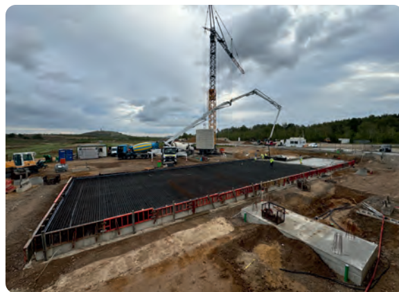
Gießen der Bodenplatte Anfang Oktober
