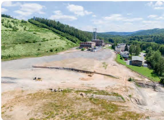
Schacht 371, Betriebsfläche Nord und Halde 371/1
