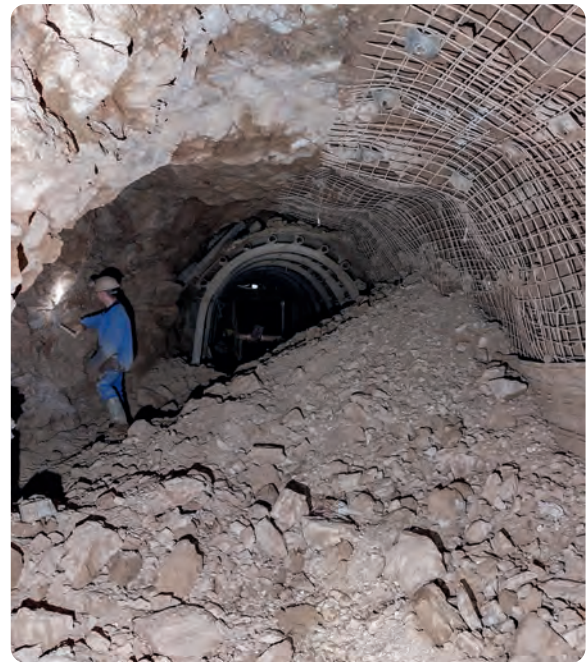
Haufwerk des ersten Abschlags
