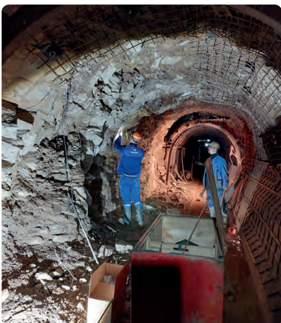
Die Sanierungsarbeiter Marc Ullman (links) und Denny Lenk beim Besetzen der Sprengscheibe des ersten Abschlags
