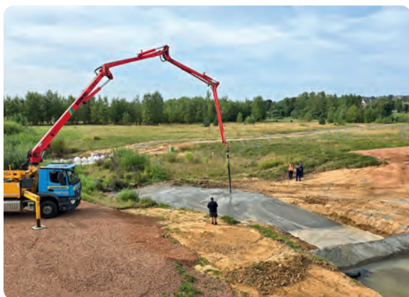
Einbau von Flüssigboden als „Fundament“ für den Absperrdamm
