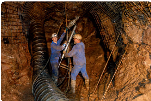
Auffahrung der Feldstrecke 27a von der Strecke 7A im Bereich Streckenkrenz Feldstrecke 27
