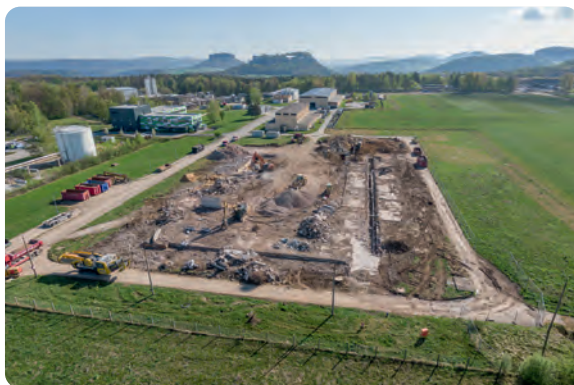
Im Frühjahr 2024 war der eigentliche Abriss beendet
