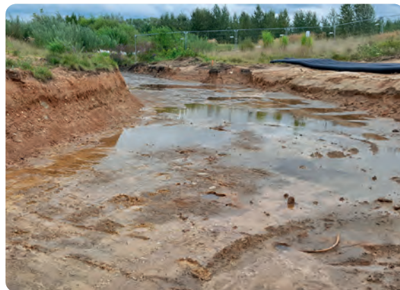
Aushub für den Absperrdamm
