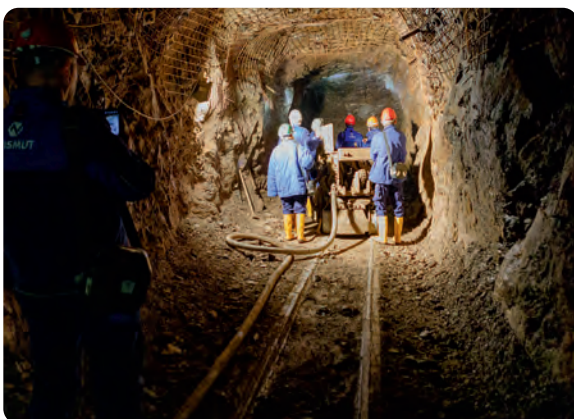
Vor Ort an der Ortsbrust der Auffahrung der Feldstrecke 27a
