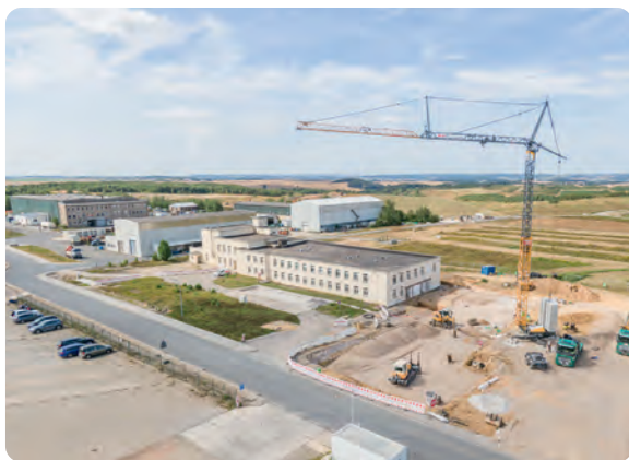
Im August begannen die Bauarbeiten am Anbau
