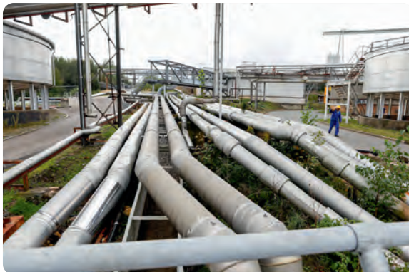
Entlang der Trasse müssen 16 km Rohrleitungen demonstert werden (Foto 2019)
