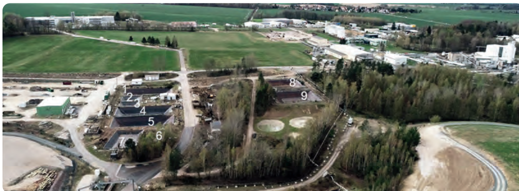
Blick auf die ehemalige Beckenwirtschaft am Wismut-Standort Königstein
