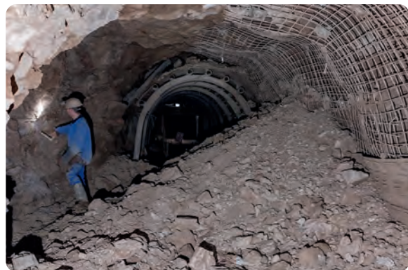
Start der Auffahrung der Feldstrecke 27a: Erster Abschlag von der Strecke 7A Anfang des Jahres
