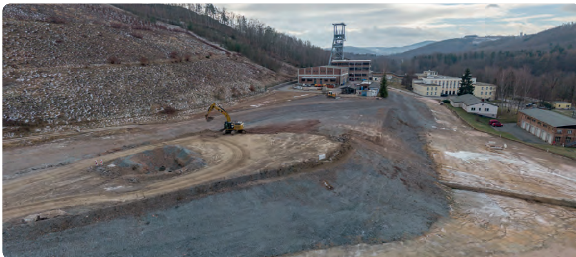
Die Betriebsfläche Nord am Schacht 371 am Fuß der Halde 371/I
