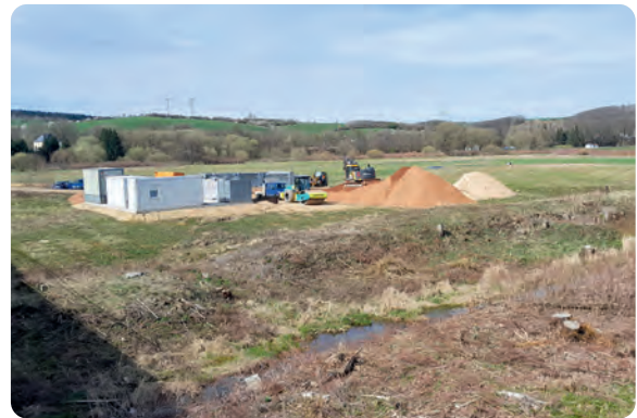
Vorbereitung der Fläche der Baustelleneinrichtung
