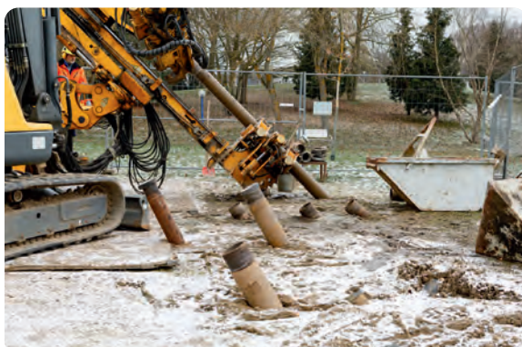
Mit den Bohrlöchern wurde das Umfeld einer ehemaligen Schachtröhre erkundet
