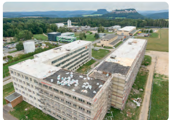
2023 begann der Rückbau
