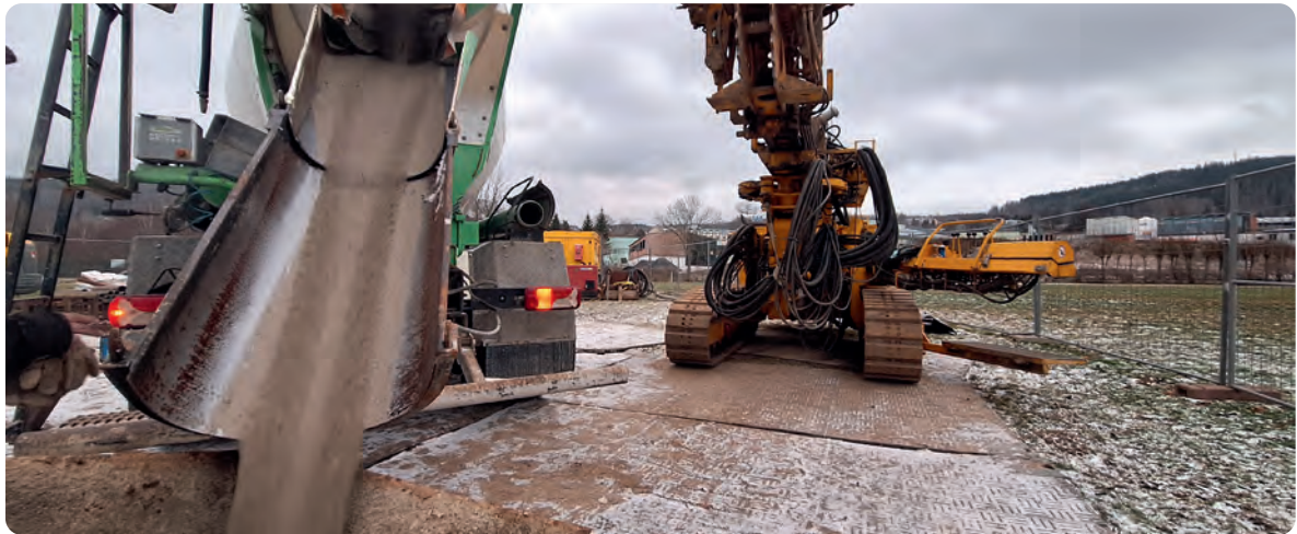
Die Bohrlöcher werden mit einer dünnflüssigen Betonsuspension verfüllt
