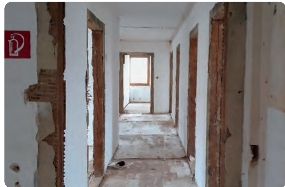
Entkerntes Obergeschoss der Verwaltung
