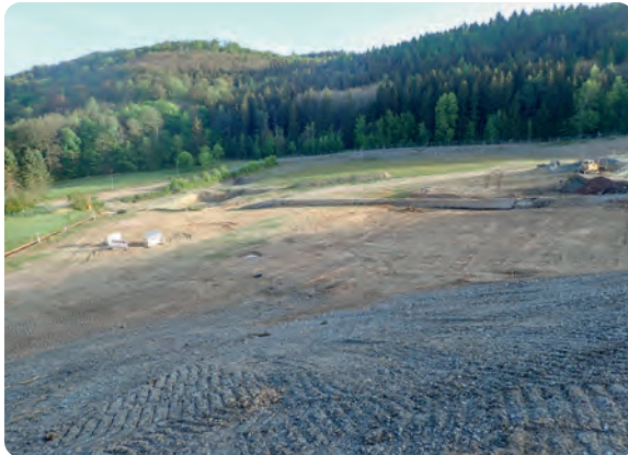
Betriebsfläche Nord am Schacht 371
