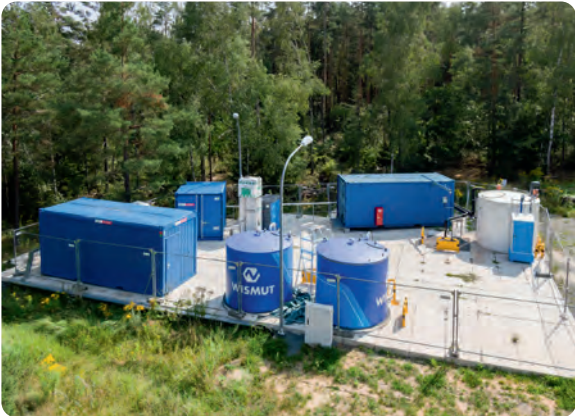
Anlagen für den Injektionsversuch am Standort Königstein
