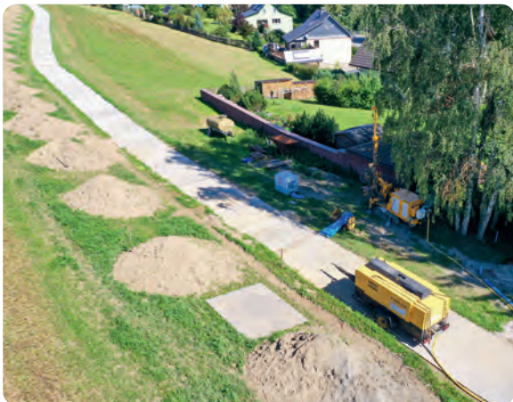
Bohrarbeiten am Schurf 347
