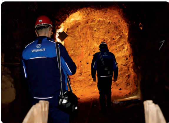
Letzte Kontrolle vor der Sprengung für den Durchbruch der Teilstrecken
