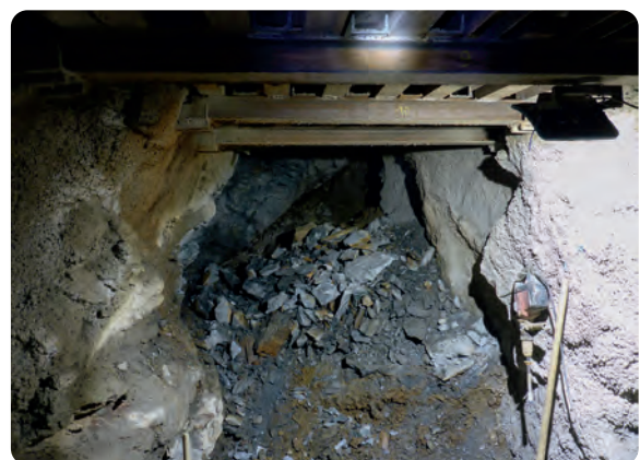
Aufwältigung mit Firstsicherung im „Bergmännisch Glück Flacher“, 2022
