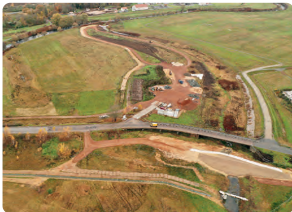
Projekt Altarm der Zwickauer Mulde. Vorn der umverlegte Schnependorfer Bach mit dem Absperrdamm.
