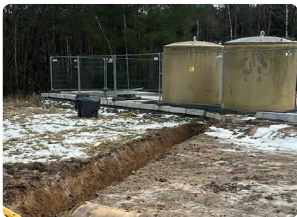
Kabelgraben zur künftigen Injektionsanlage
