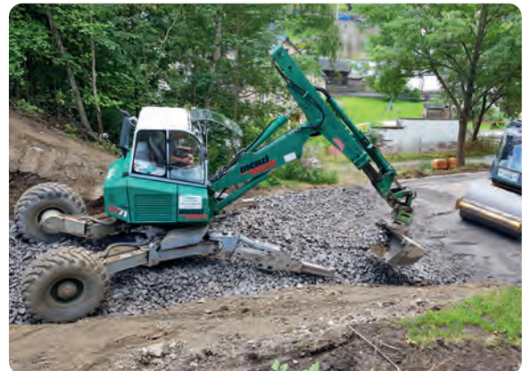
Herstellung der Zufahrt zum „Glück Auf Stolln“ mit Schreibagger, 2021
