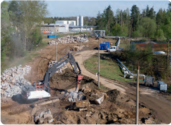
Rückbau der Rohrtrassen der Uranabtrennung am Standort Königstein
