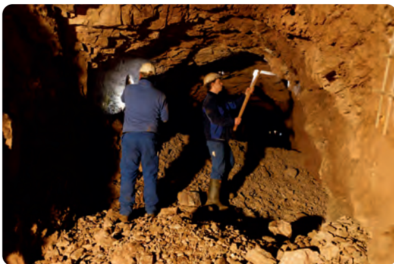
Bereifen der Firste und Stöße
