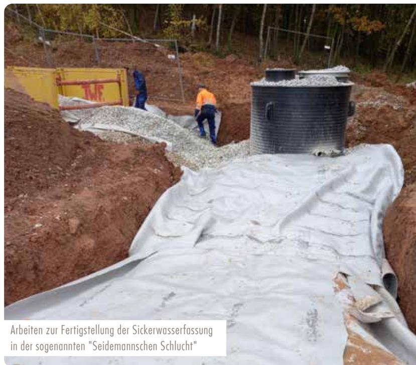
Arbeiten zur Fertigstellung der Sickerwasserfassung in der sogenannten "Seidemanschen Schlucht"
