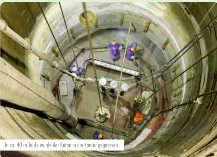
In ca. 40 m Teufe wurde der Beton in die Kontur gegossen.
