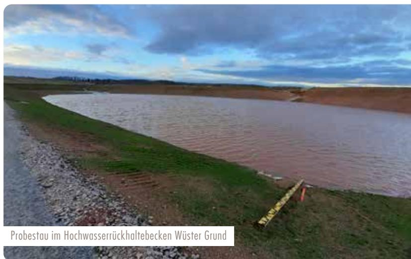
Probestau im Hochwasserrückhaltebecken Wüster Grund
