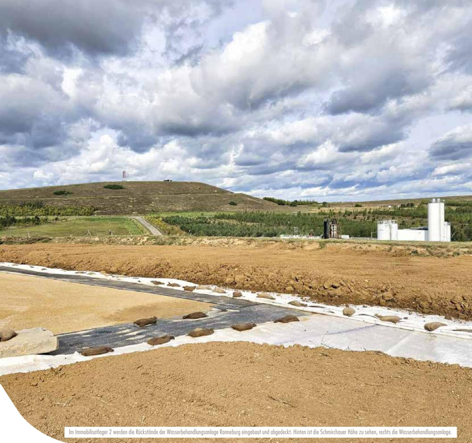
Im Immobilisatager 2 werden die Rückstände der Wasserbehandlungsanlage Ronneburg eingebaut und abgedeckt. Hinten ist die Schmirchauer Höhe zu sehen, rechts die Wasserbehandlungsanlage.
