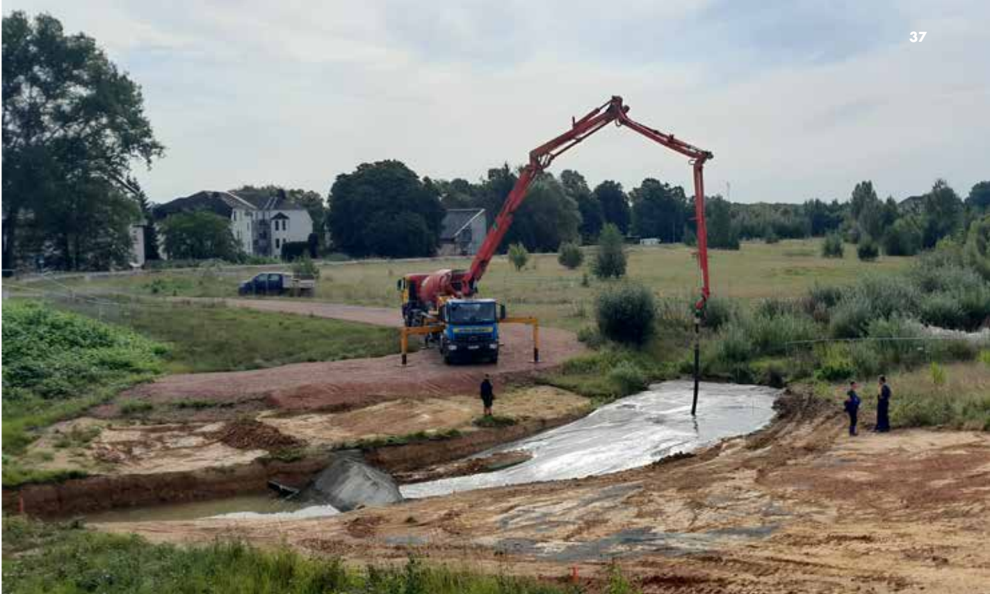
Altarm Zwickauer Mulde, Einbau von Flüssigboden als „Fundament“ für den Absperrdamm
