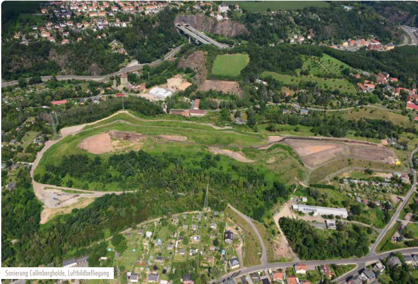
Sanierung Collmberghalde, Reifenwaschanlage und Abrollstrecke
