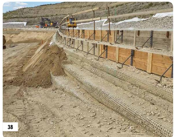
**39** Südostböschung, Bereich der fertiggestellten Stützkonstruktion „Bewehrte Erde“, Dezember 2023
