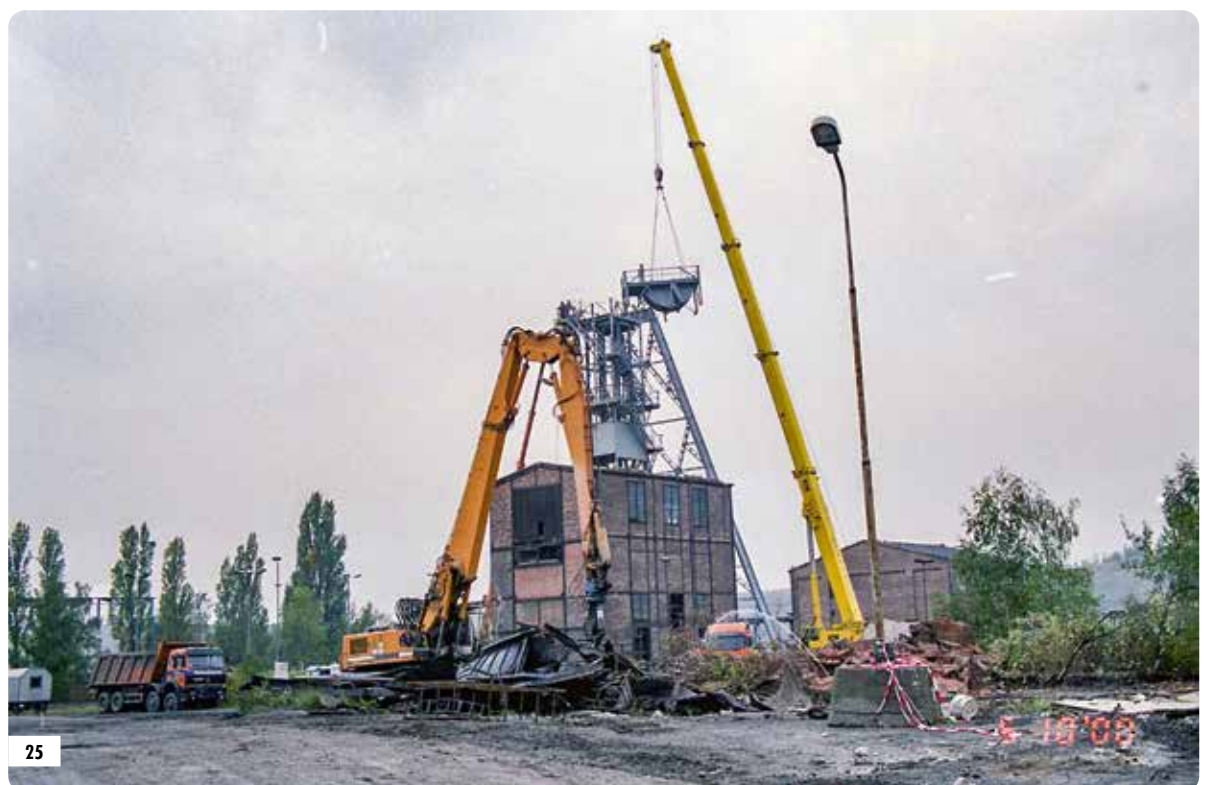
25 Demontage des Fördergerütes Schacht 375 am 5. Oktober 2000 im Betriebsteil Lichtenberg
