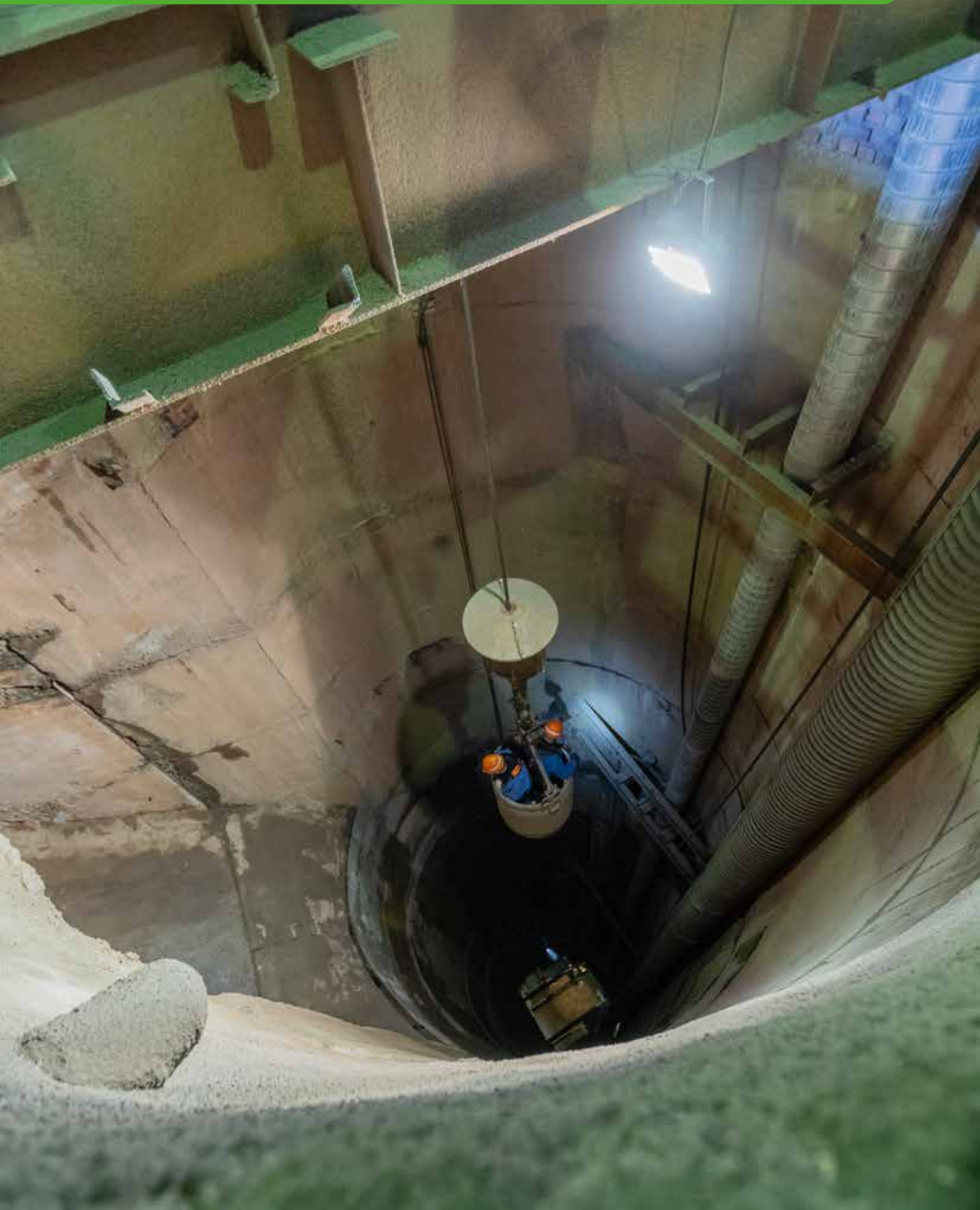
13 Befahrung des Schachtes 208 im Mai im Kübel. Die Ziegelmauerung des Schachtkragens unter der neuen Trägerlage ist teilweise schon mit Spritzbeton gesichert. In knapp 50 m Tiefe ist eine Montagebühne zu sehen.
