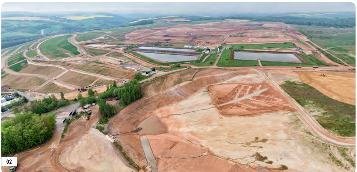
02 Auch auf der Absetzanlage Culmitzsch wird die Kernsanierung 2028 beendet sein
