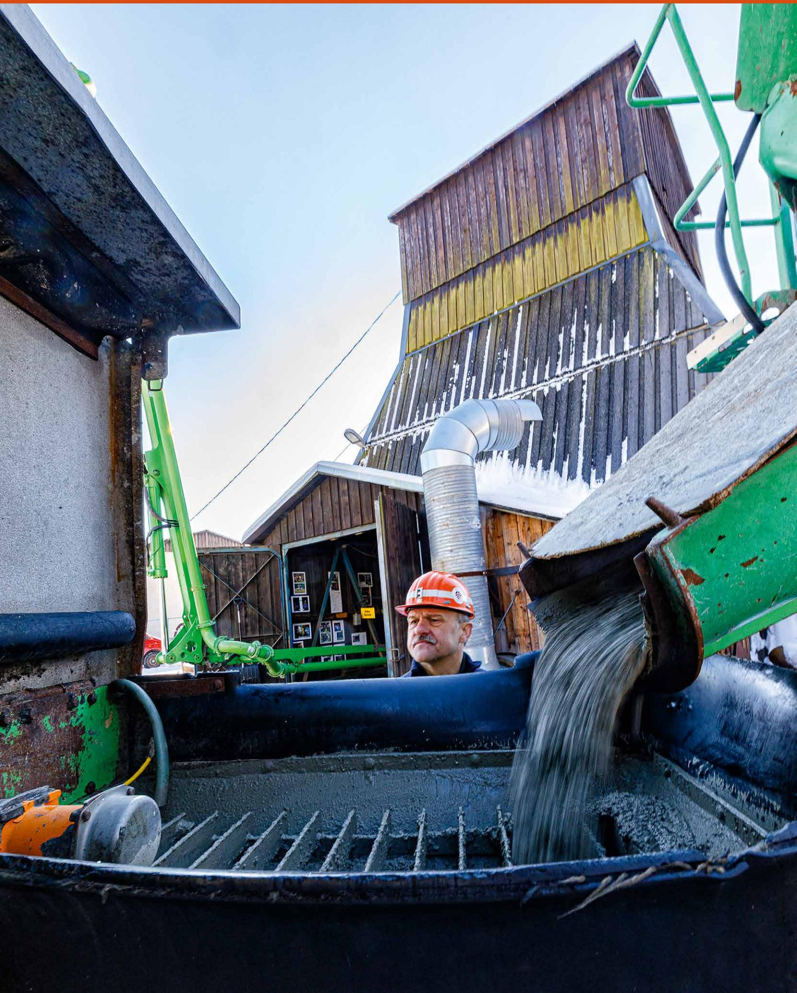
42 Für Mario Igler vom Projekt Bergbau/Sanierung am Standort Aue ist die Verwahrung des Schachts 208 in Aue-Bad Schlema das letzte große Vorhaben seines Berufslebens. Ende Februar überwachte er die Anlieferung des Betons für das Betonieren der Tragplatte in der Schachtröhre.
