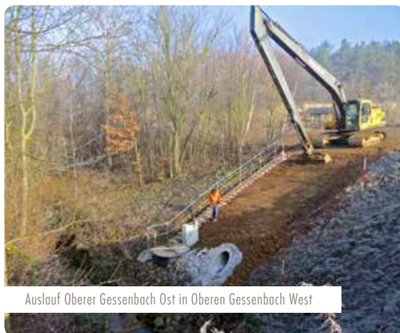
Bauarbeiten am Oberen Gessenbach Ost, nördlich des Pohlteiches
