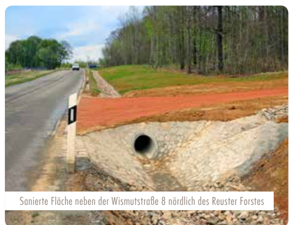
Aufforstung des Aufschüttkörpers
