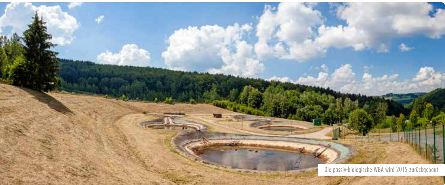
Die umgebaute konventionelle Wasserbehandlungsanlage
