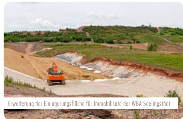
IAA Culmitzsch – Becken A. Zwischenabdeckung
