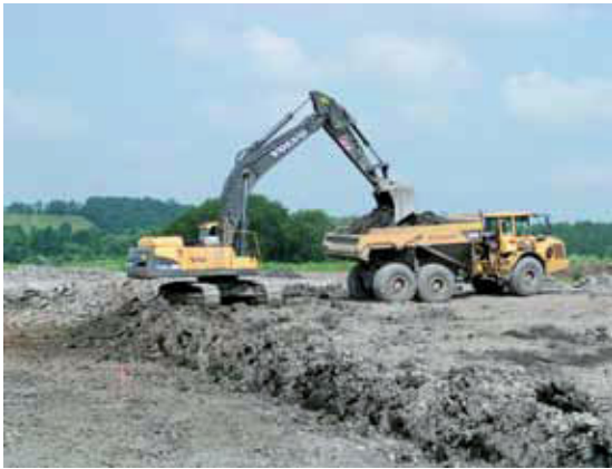
Abtragsarbeiten im Nordbereich der Bergehalde Crossen (Bild 7.1-4)
