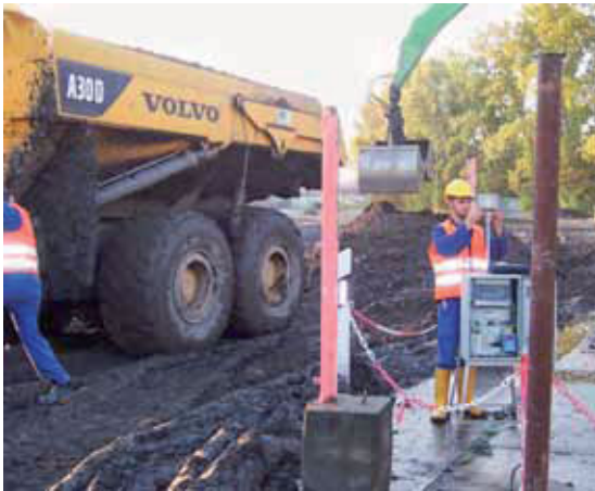
Sanierungsbegleitende Messungen von langlebigen Alphastrahlern an der Aufgabestelle des Pipe Conveyors (Schlauchbandförderanlage) Crossen (Bild 7.2-3)
