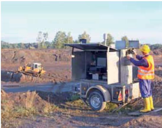
Filterwechsel an einem Staubprobensammler zur Messung langlebiger Alphastrahler im Schwebstaub an einer transportablen Messeinrichtung zur Überwachung des Abtrages der Bergehalde Crossen (Bild 7.2-4)
