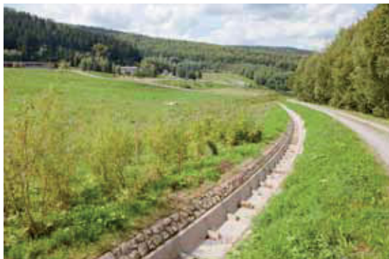
Oberflächenentwässerung auf der Luchsbachhalde, August 2009 (Bild 3.1-1)
