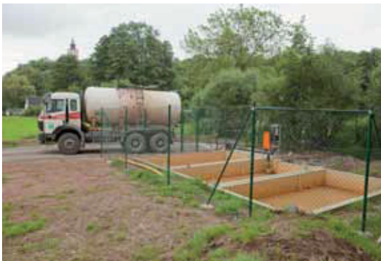
Stapelbecken zur Fassung des kontaminierten Grundwassers dahinter Tankfahrzeug zum Transport des gefassten Wassers (Bild 6.1-7)
