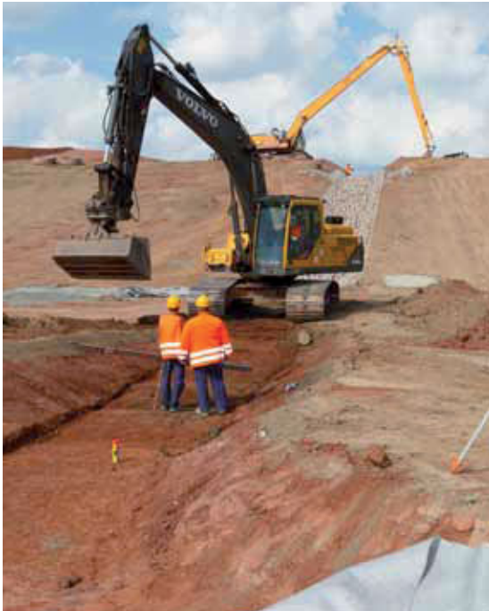
Herstellung des Ableitungsgerinnes von der Dammböschung der IAA Dänkriz I (Bild 7.1-2)
