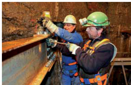
Montage der Grundträger für die Arbeitsbühne im Schacht 371 (Bild 2.1-4)
