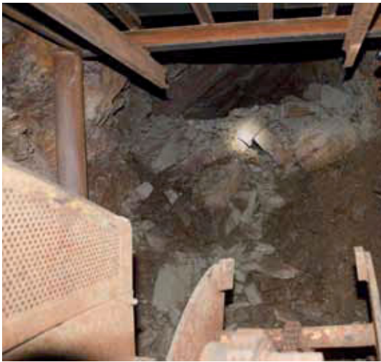
Verbruchmassen an einem Streckenkreuz im Querschlag 14 (Bild 2.1-1)
