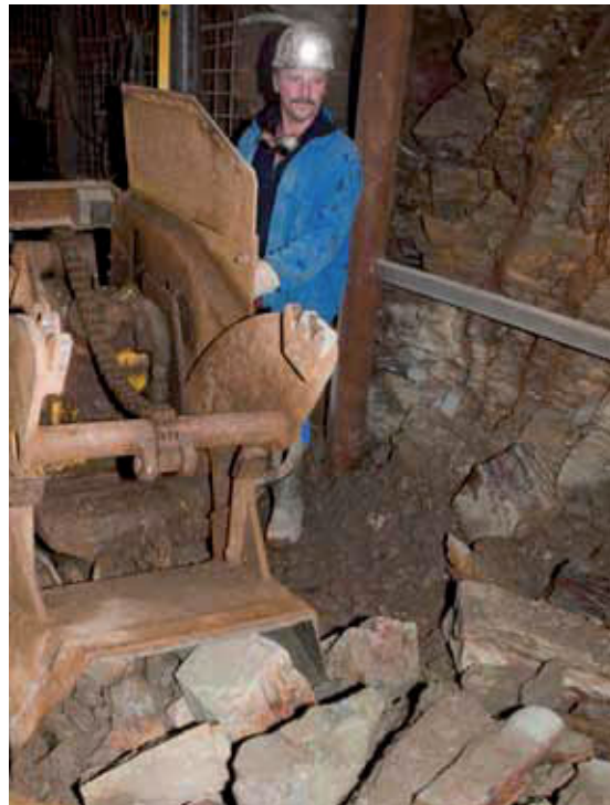
Ladearbeiten bei der Aufwältigung von Querschlag 14 (Bild 2.1-2)
