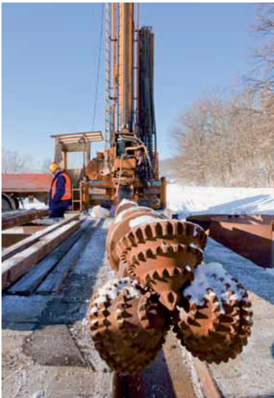
Errichtung des Brunnen 6, im Vordergrund Rollmeißelkronen (Bild 6.1-3)
