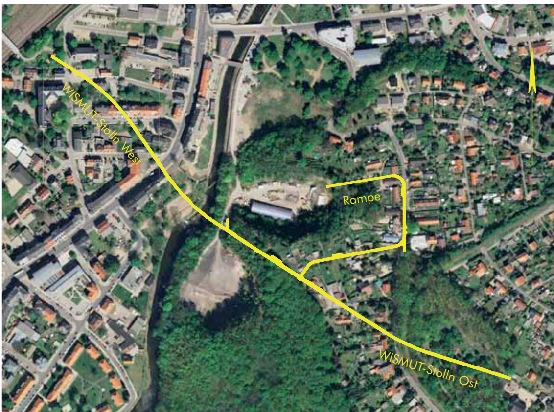
Stollenauffahrung bis Ende 2009, dargestellt auf einer Luftbildaufnahme (Bild 5.1-6)
