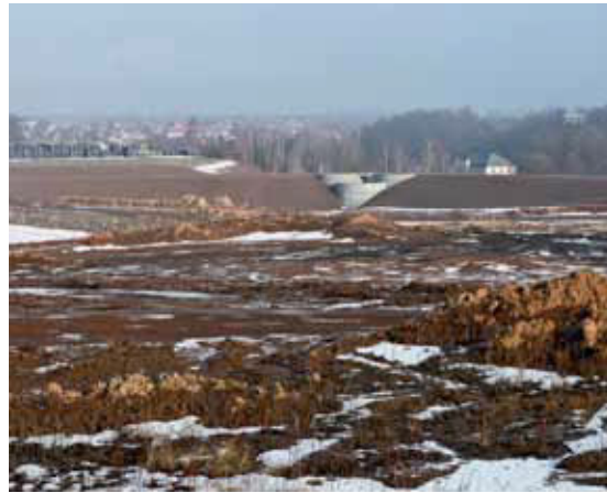
Regenrückhaltebecken Z (Bild 6.1-10)
