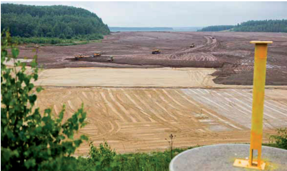
Einbau der Flächendränage und der Konturschüttung im Becken B, Juni 2009 (Bild 8.1-5)
