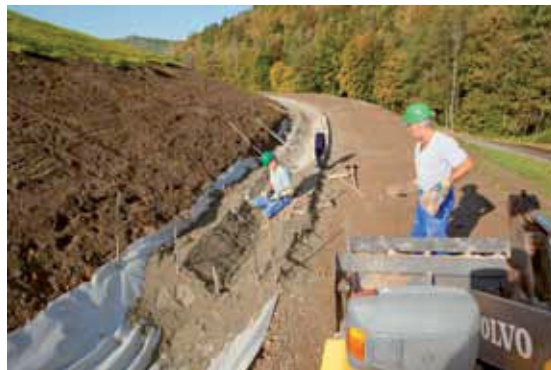
Pflasterarbeiten beim Wasserbau auf der Halde 66/207 (Bild 2.1-7)
