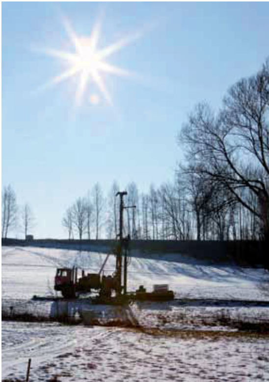
Bohrlochverwahrung im Gessental (Bild 6.1-2)
