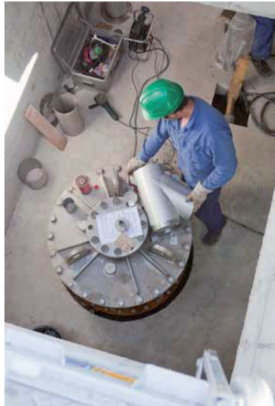
Über Tage - Ansicht Bauphase Brunnenstube Förderbohrloch Aneu (Bild 4.1-2)
