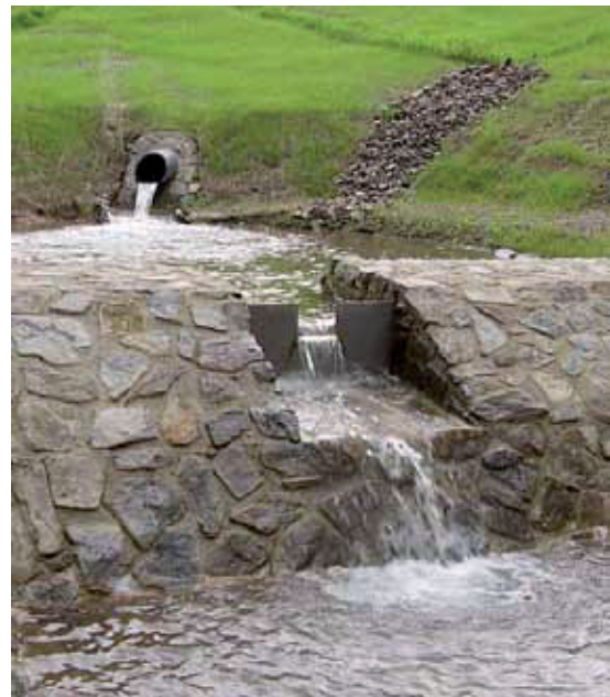
Zentrale Sickerwassermessstelle m-580 am Fuß Halde 371/II, Juli 2009 (Bild 2.2-1)
