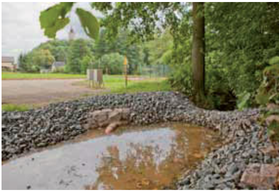
Wassersperre in der Postersteiner Sprotte (Bild 6.1-6)
