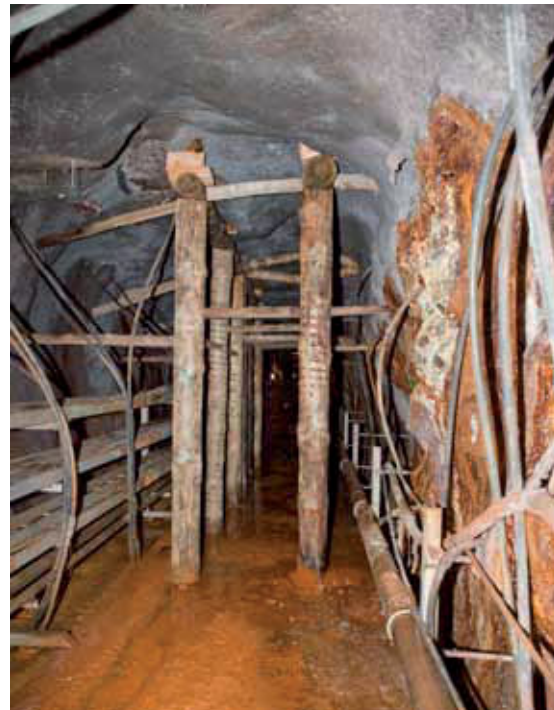
Rückzugsvorbereitung aus der Kontrollstrecke (Ausbaustärkung) (Bild 4.1-3)
