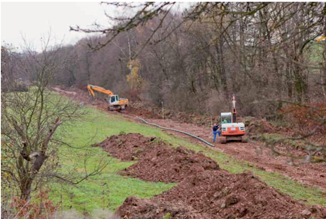
Herstellung der Direktverstrahlleitung im Bereich der Postersteiner Sprotte (Bild 6.1-8)
