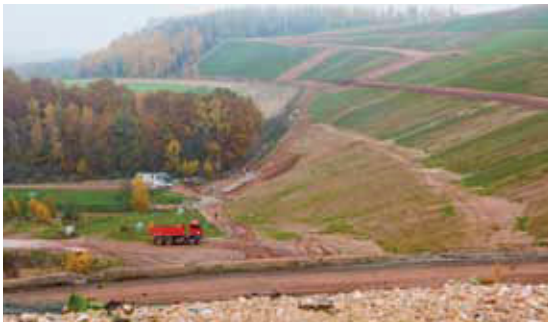
Konturierter und begrünter Norddamm mit Wasser- und Wegebauarbeiten (Bild 8.1-4)
