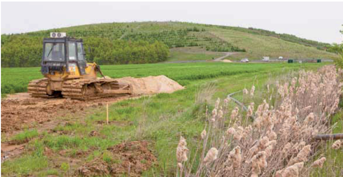
Herstellung der Sickerwasserleitung Halde Beerwalde (Bild 6.1-1)
