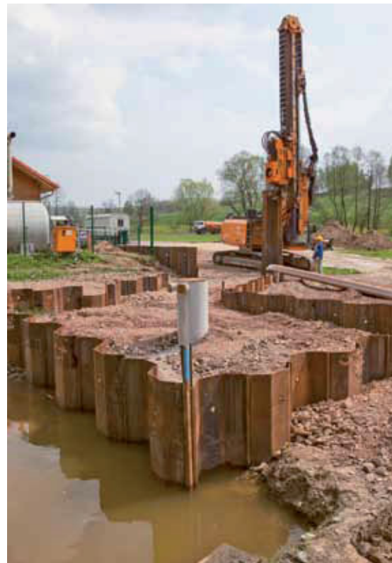
Einbringen von Spundwänden am Brunnen 6 (Bild 6.1-4)
