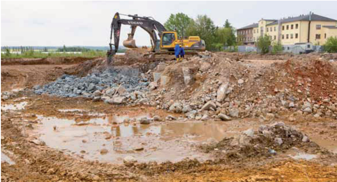
Abbrucharbeiten an massiven Betonfundamenten im Rahmen der Flächensanierung Betriebsfläche Seelingstädt, im Hintergrund Laborgebäude (Bild 8.1-6)
