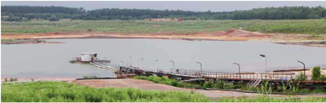
Restseefläche der IAA Culmitzsch, Becken A, mit schwimmender Pumpstation (Bild 8.1-3)
