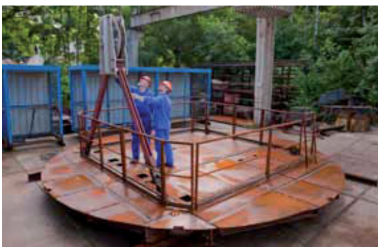
Demontage der vorgefertigten Betonierbühne für den nachfolgenden Einbau im Schacht 371 (Bild 2.1-3)
