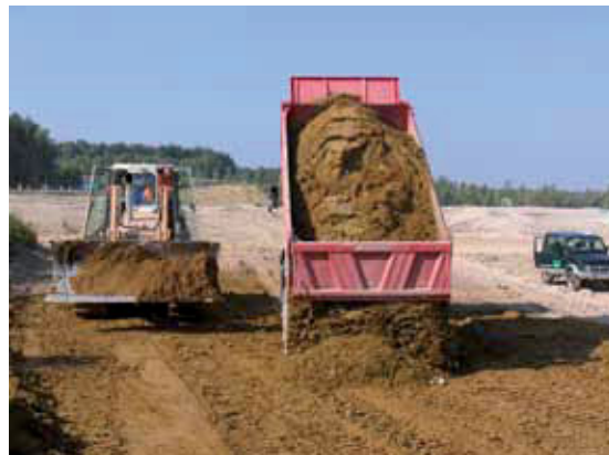
Herstellung des technologischen Prüffeldes im Bauabschnitt 1 der Halde (Bild 4.1-5)
