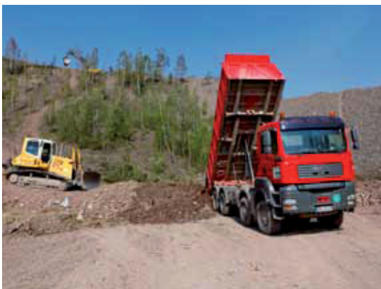
Auftrag von Haldenmaterial auf der Betriebsfläche Schacht 12 im Vorfeld der Halde 309 (Bild 2.1-6)
