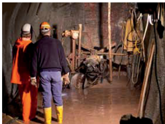
Stollnauffahrung nach West, Ortsbrust mit NKR-Bohrmaschine für Erkundungs- und nachfolgende Verpressarbeiten (Bild 5.1-1)
