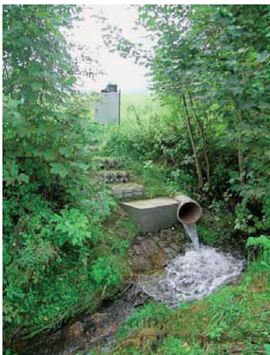
Einleitung von Infiltrationswasser Grube Pöhla in den Schildbach am Messpunkt m-168A (Bild 3.2-1)
