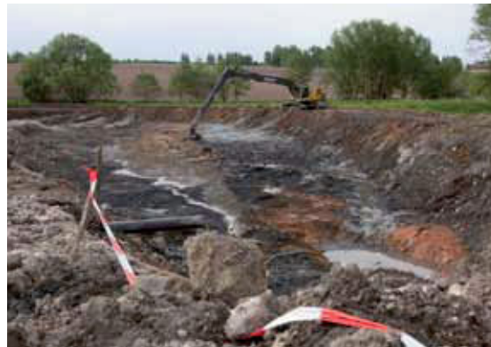
Pohlteich während der Sanierung (Bild 6.1-12)
