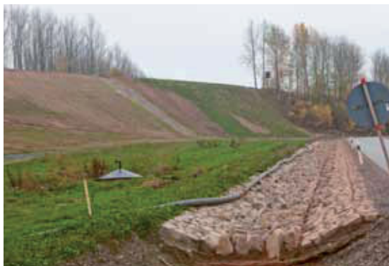
Vorschüttung Katzensgrund mit Gerinnen zur Oberflächenwasserabführung (Bild 8.1-1)
