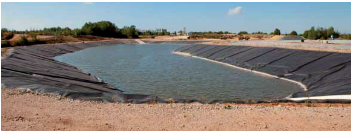
Befüllung des Speicher- und Homogenisierungsbeckens zum Probetrieb (Bild 7.1-3)
