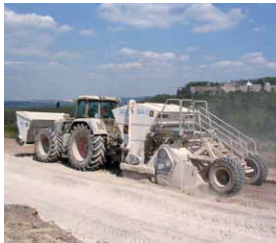
Technik zum Aufbringen und Einarbeiten des reaktiven Materials auf der Halde Schlüsselgrund (Bild 4.1-4)
