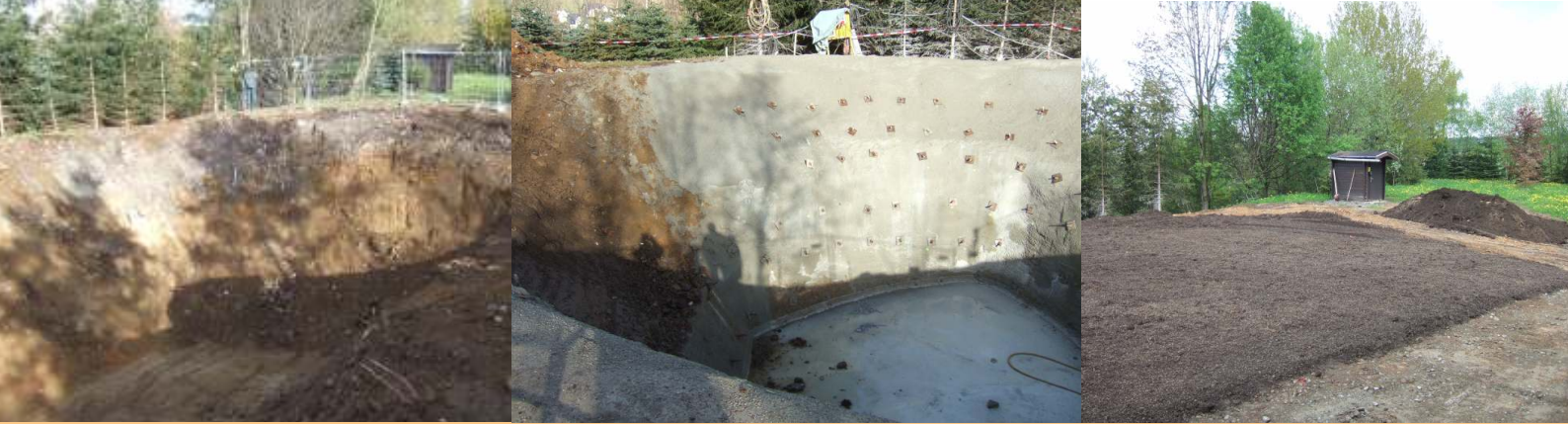
Verwahrung des Schachtes 249, Sehmatal
