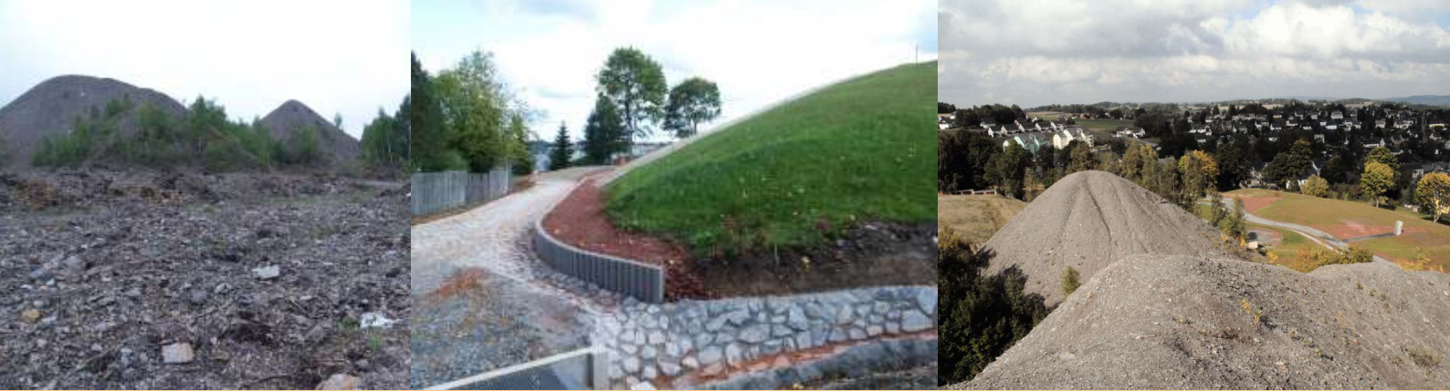
Sanierung der Halde 116 (Drei Könige), Annaberg-Buchholz
