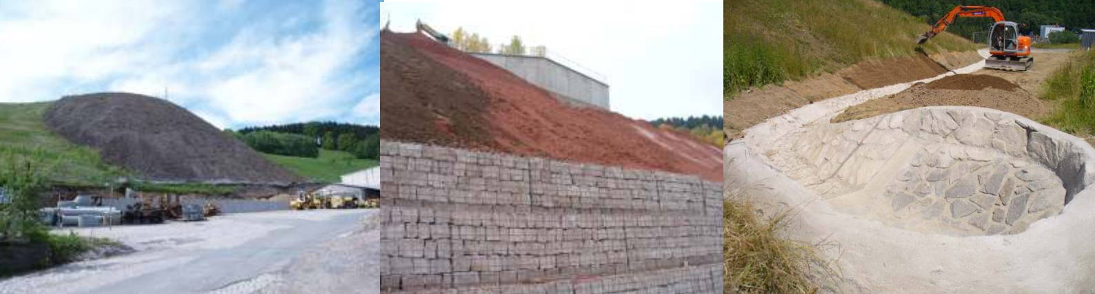
Sanierung der Halde 278, Schwarzenberg
