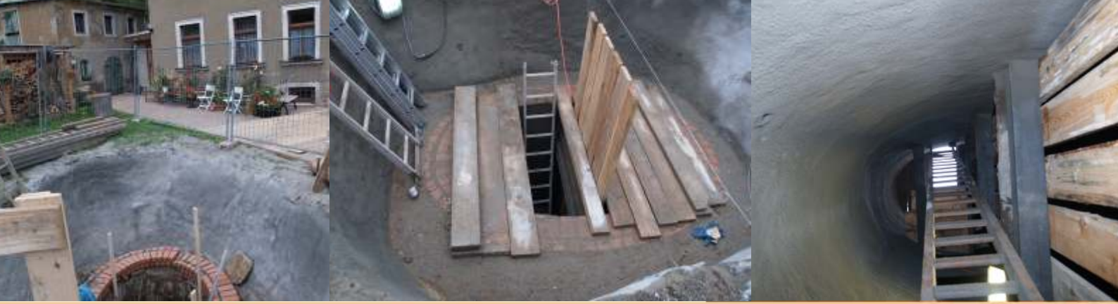
Verwahrung Lichtloch 3 des Bierschnabel-Stollns, Annaberg-Buchholz
