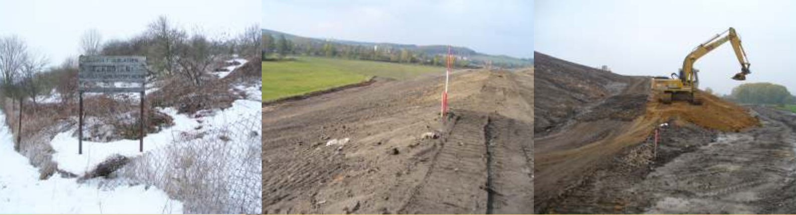
Sanierung der Halde Crossen, Zwickau
