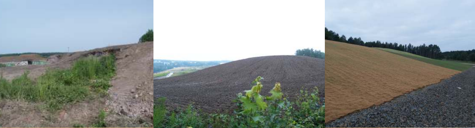
Sanierung der Armerzhalde Zobes, Neuensalz
