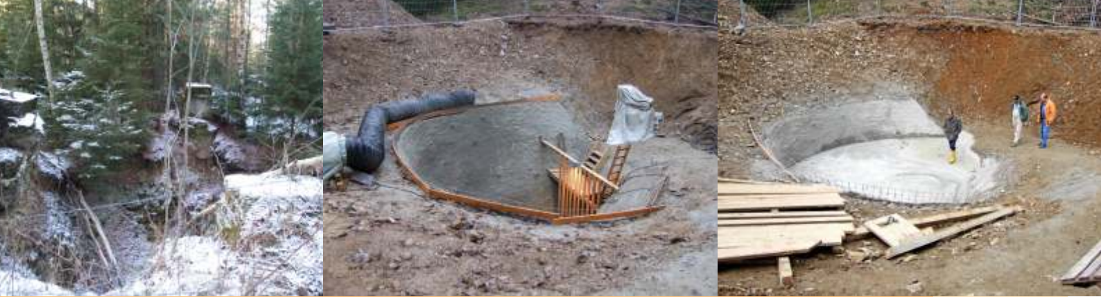
Verwahrung des Schachtes 315, Lößnitz
