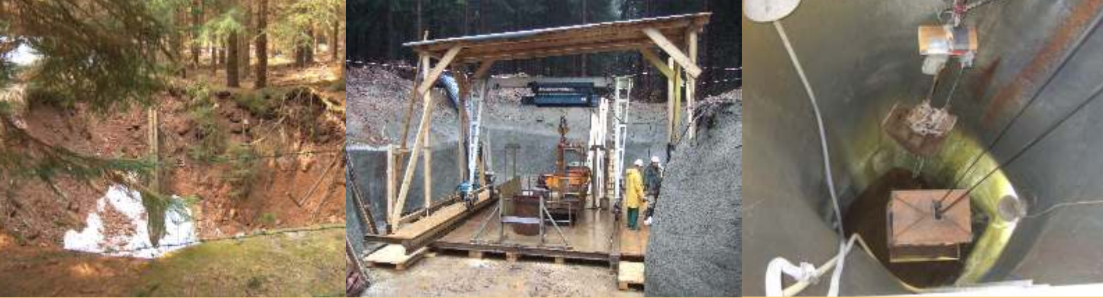
Arbeiten im Verwahrbereich 1, Tannenbergesthal
