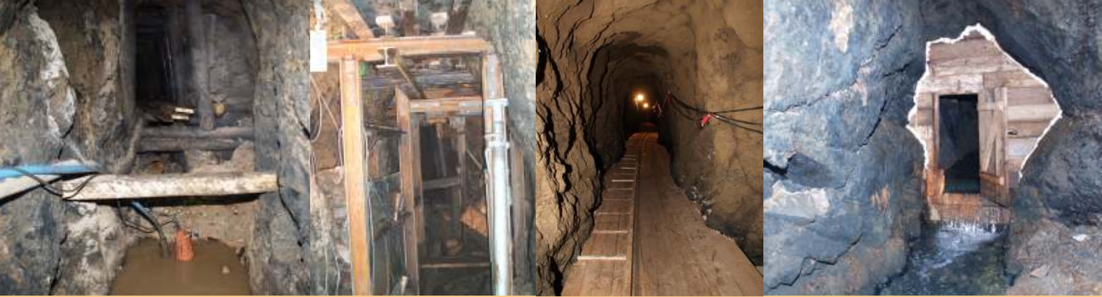
Sicherung des Markus-Semmler-Stollns, Schneeberg
