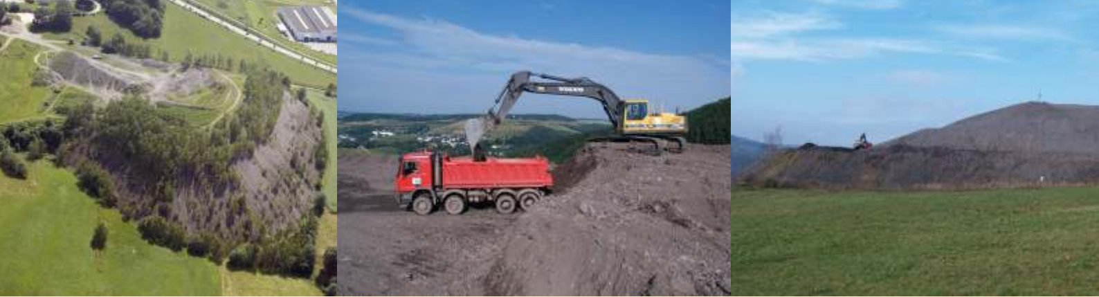
Sanierung der Halde 296, Aue
