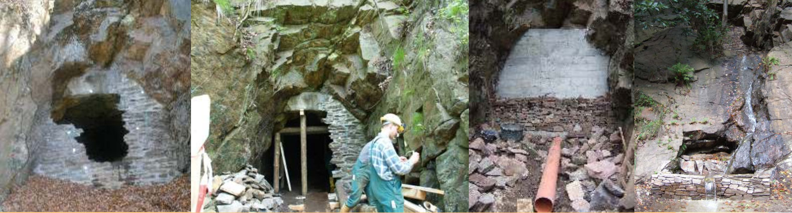
Verwahrung des Stollns 7, Bernsbach
