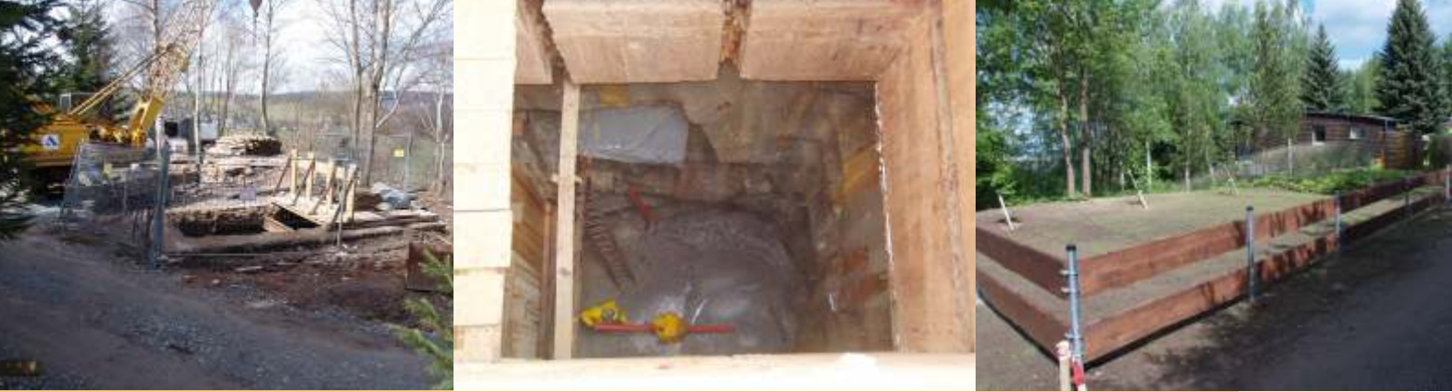
Verwahrung des Schachtes 308, Schwarzenberg
