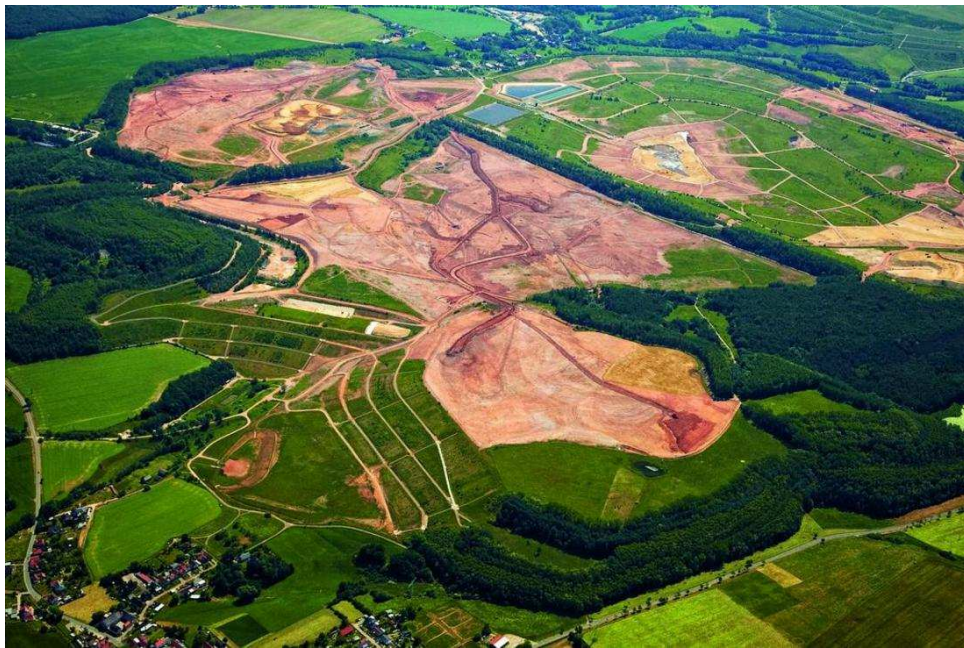
Gesamtansicht der Industriellen Absetzanlage Culmitzsch, 2016
